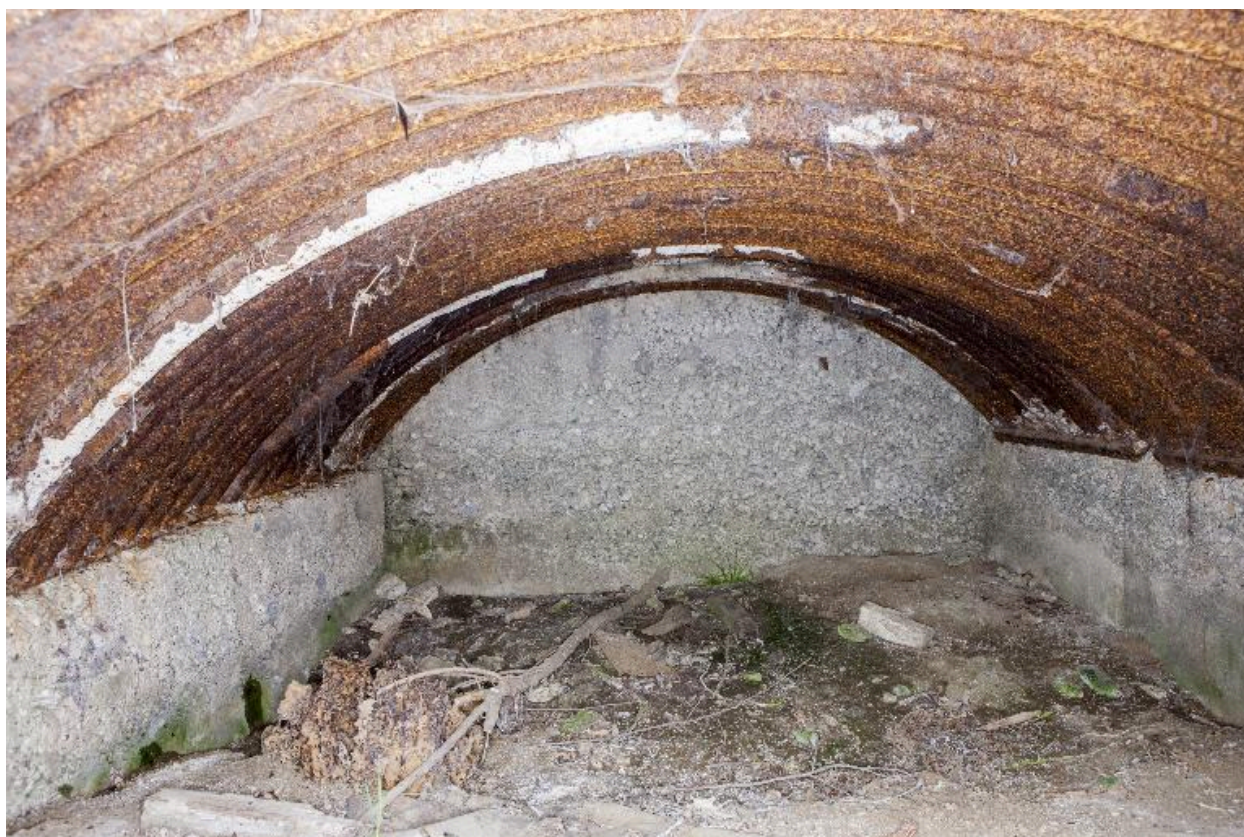
Vue intérieure de l'abri
