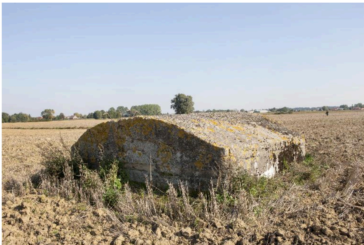
Pignon nord, vers sud-est
