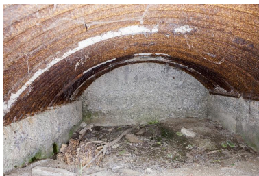
Vue intérieure de l'abri Phot. Pierre Thibaut IVR31_20155901696NUCA
