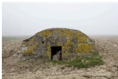
Pignon avec entrée, vers le nord-ouest Phot. Pierre Thibaut IVR31_20145905440NUCA
