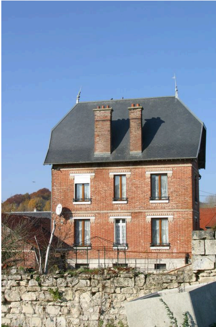
Vue générale de la façade postérieure.
