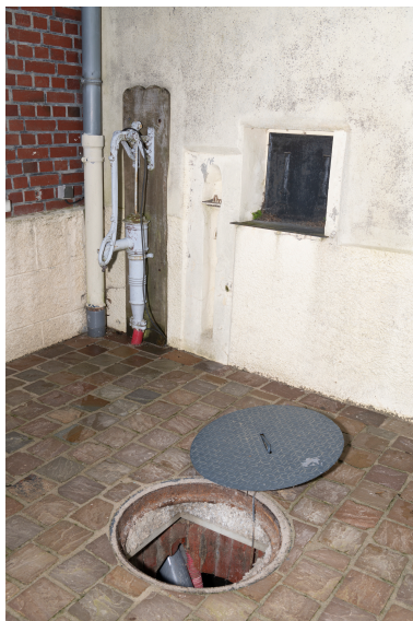
Citerne enterrée en brique avec pompe, n°3 de la rue de la Plaine. Phot. Marc Kérignard IVR32_20246000399NUCA
