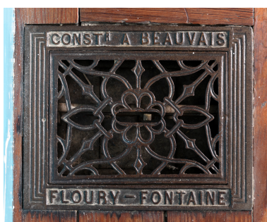
Grille de chauffage, signée Floury-Fontaine à Beauvais; n°3 de la rue de la Plaine. Phot. Marc Kérignard IVR32_20246000394NUCA
