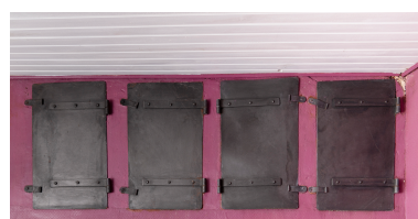
Portes d'accès aux conduits de chauffage, comble du n °3 de la rue de la Plaine. Phot. Marc Kérignard IVR32_20246000395NUCA
