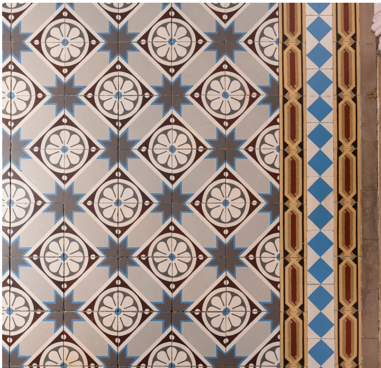
Carrelage en carreaux de ciment, n°3 de la rue de la Plaine.
