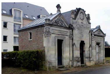
Vue de situation, tombeau au deuxième plan. Phot. Thierry Lefébure IVR22_20058000379NUCA
