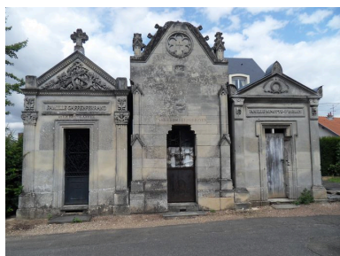
Vue générale, tombeau au centre de l'image. Phot. Isabelle Barbedor IVR22_20098010004NUCA
