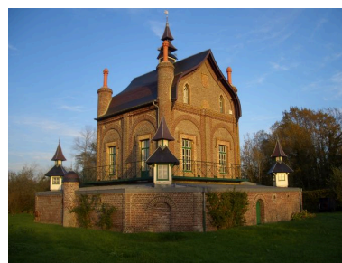
Vue générale, depuis l'ouest. Phot. Inès Guérin IVR22_20048001129NUCA
