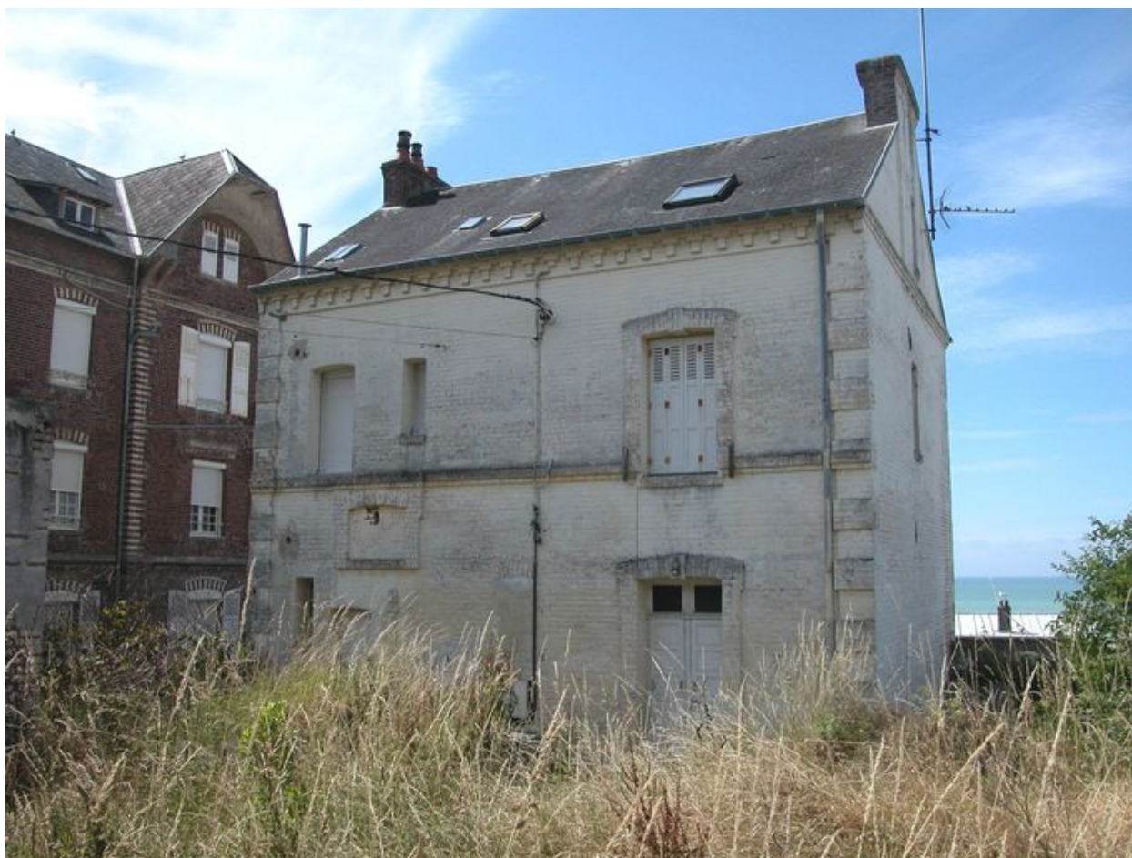
Elévation postérieure depuis la rue Gros.
