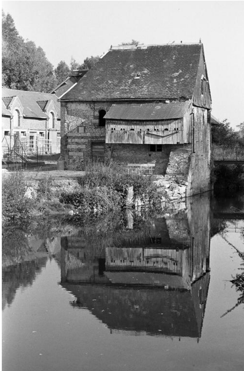
Vue du bâtiment d'eau, donnant sur le Noirieux.
