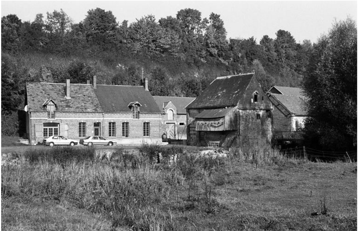
Vue d'ensemble des bâtiments, depuis le sud-est.
