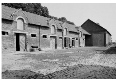
Vue de l'étable et de la grange, depuis le nord-ouest. Phot. Thierry Lefébure IVR22_19920203101Z
