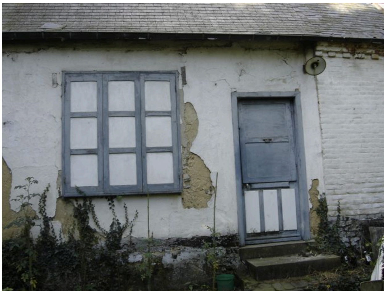
Détail de la porte d'entrée et de la fenêtre large.
