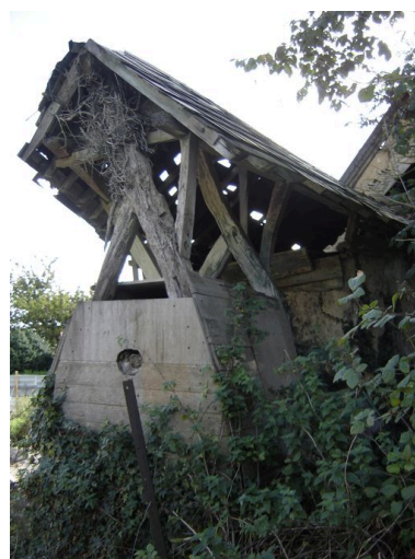
Vue du puits. Phot. Inès Guérin IVR22_20078005319NUCA
