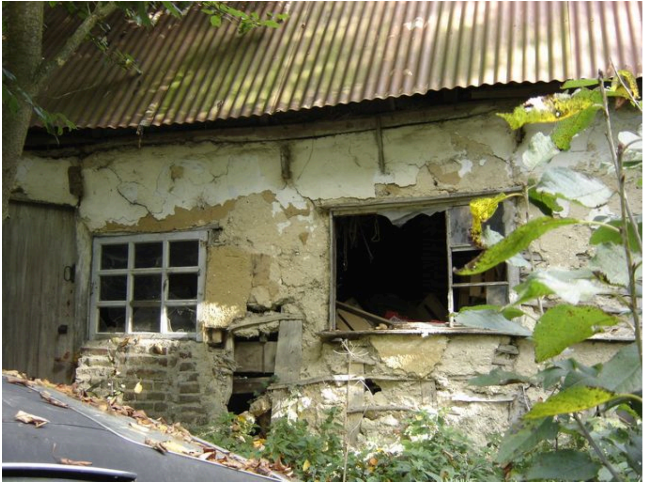
Vue des huisseries du bâtiment situé au sud.
