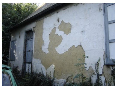
Détail des deux dernières travées. Phot. Inès Guérin IVR22_20078005311NUCA
