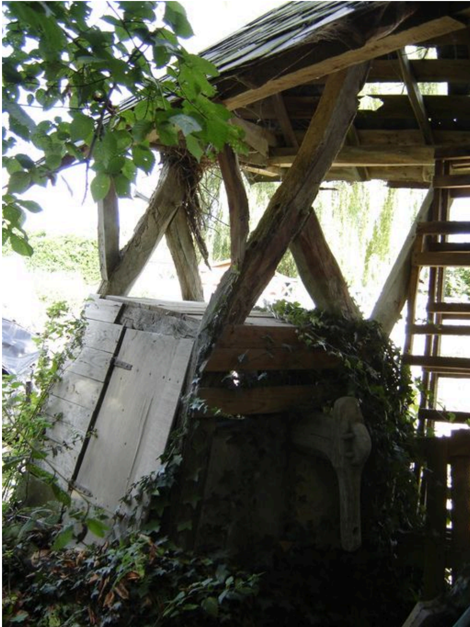
Autre vue latérale du puits.
