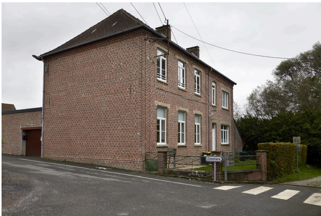
Façade sud et pignon ouest.
