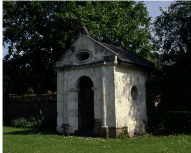
Vue générale, depuis le nord-ouest. Phot. Marie-Laure Monnehay-Vulliet IVR22_20108000234XA
