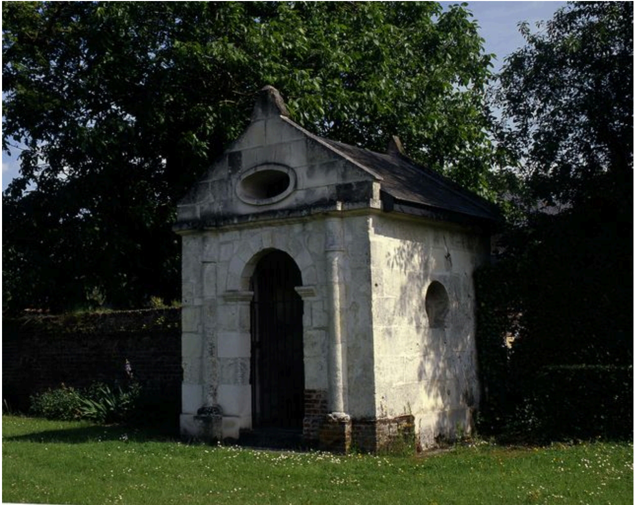
Vue générale, depuis le nord-ouest.
