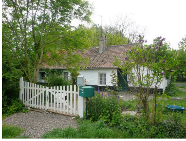
Vue générale. Phot. Inès Guérin IVR22_20078005776NUCA
