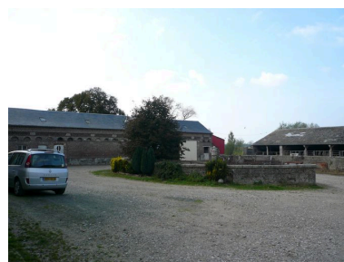
Vue des étables et du pédiluve au centre de la cour.
