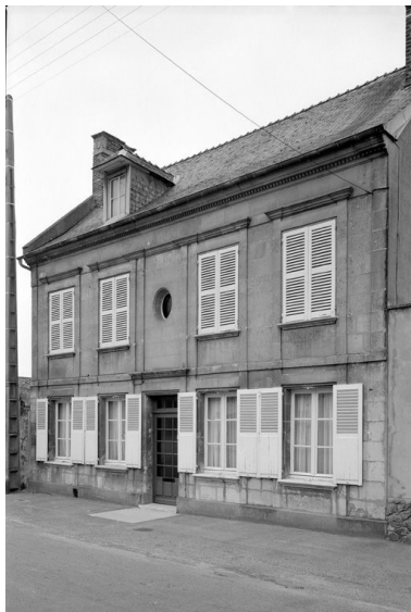
Elévation antérieure. Phot. Jean-Michel Perrin IVR22_19846001055X
