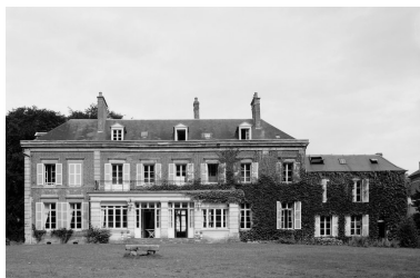
Logis. Elévation postérieure. Phot. Jean-Michel Perrin IVR22_19846000949V
