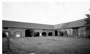
Ferme. Vue générale. Phot. Jean-Michel Périn IVR22_19846000955V
