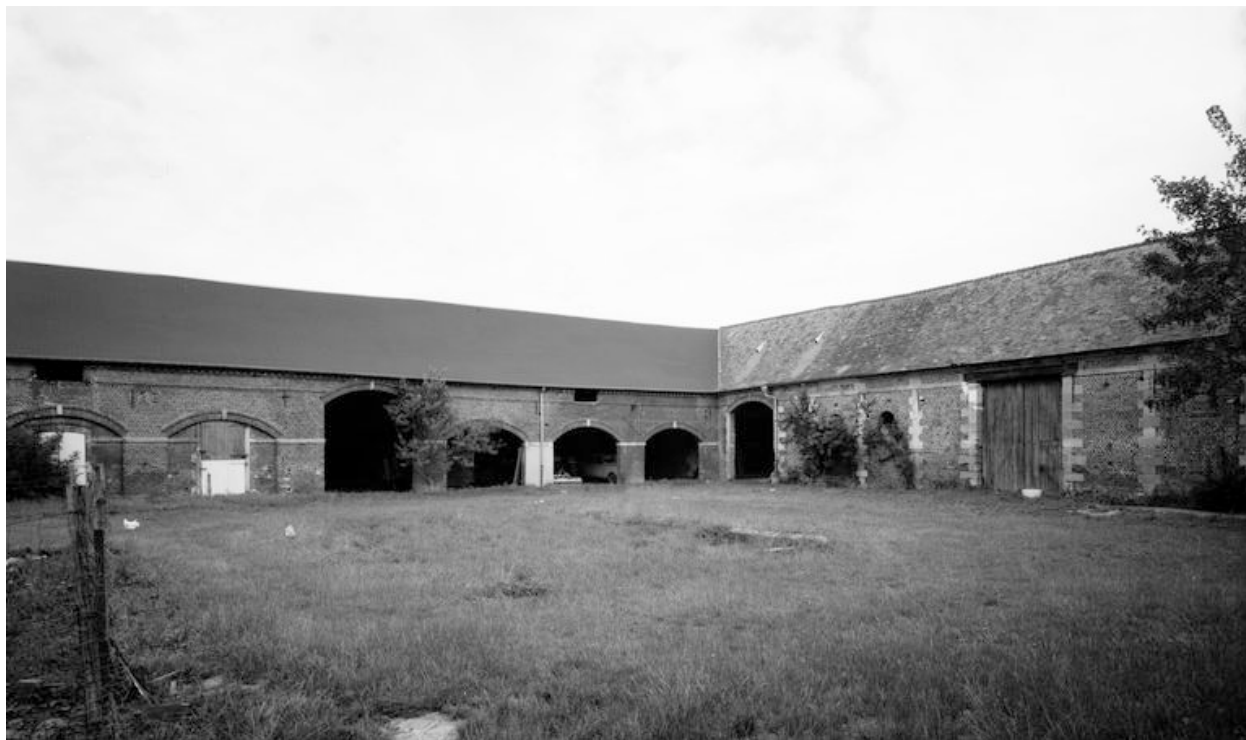
Ferme. Vue générale.
