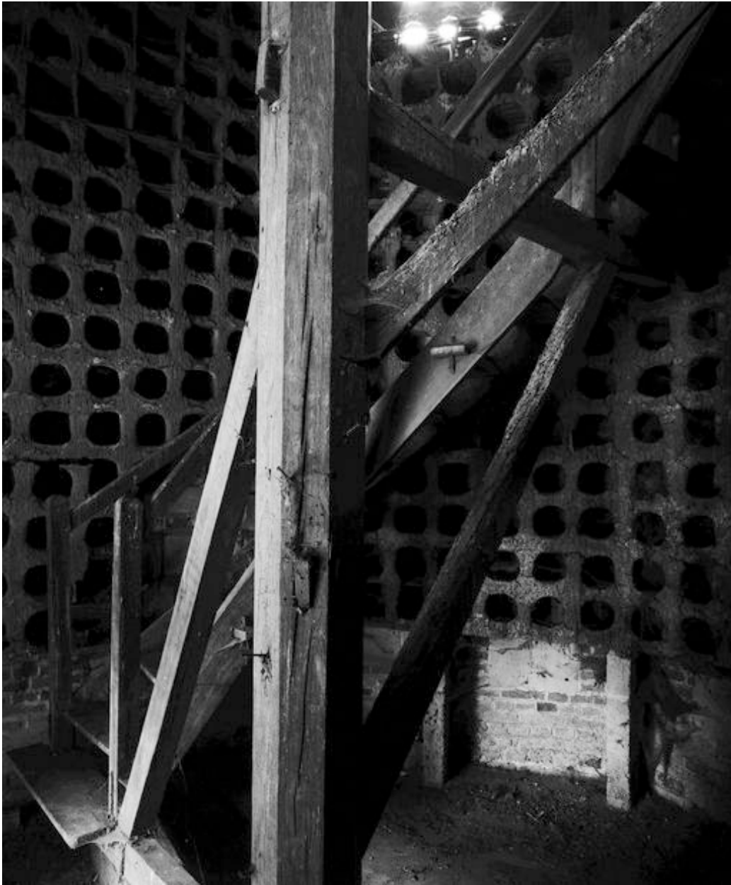
Colombier. Vue intérieure.
