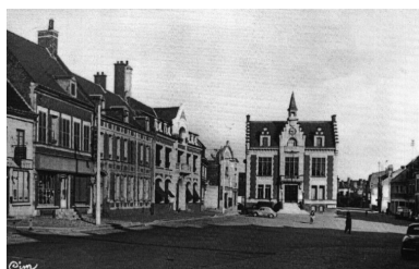
Place de l'Hôtel de ville avec vue de la maison (AD Somme ; 8 Fi 1738).
