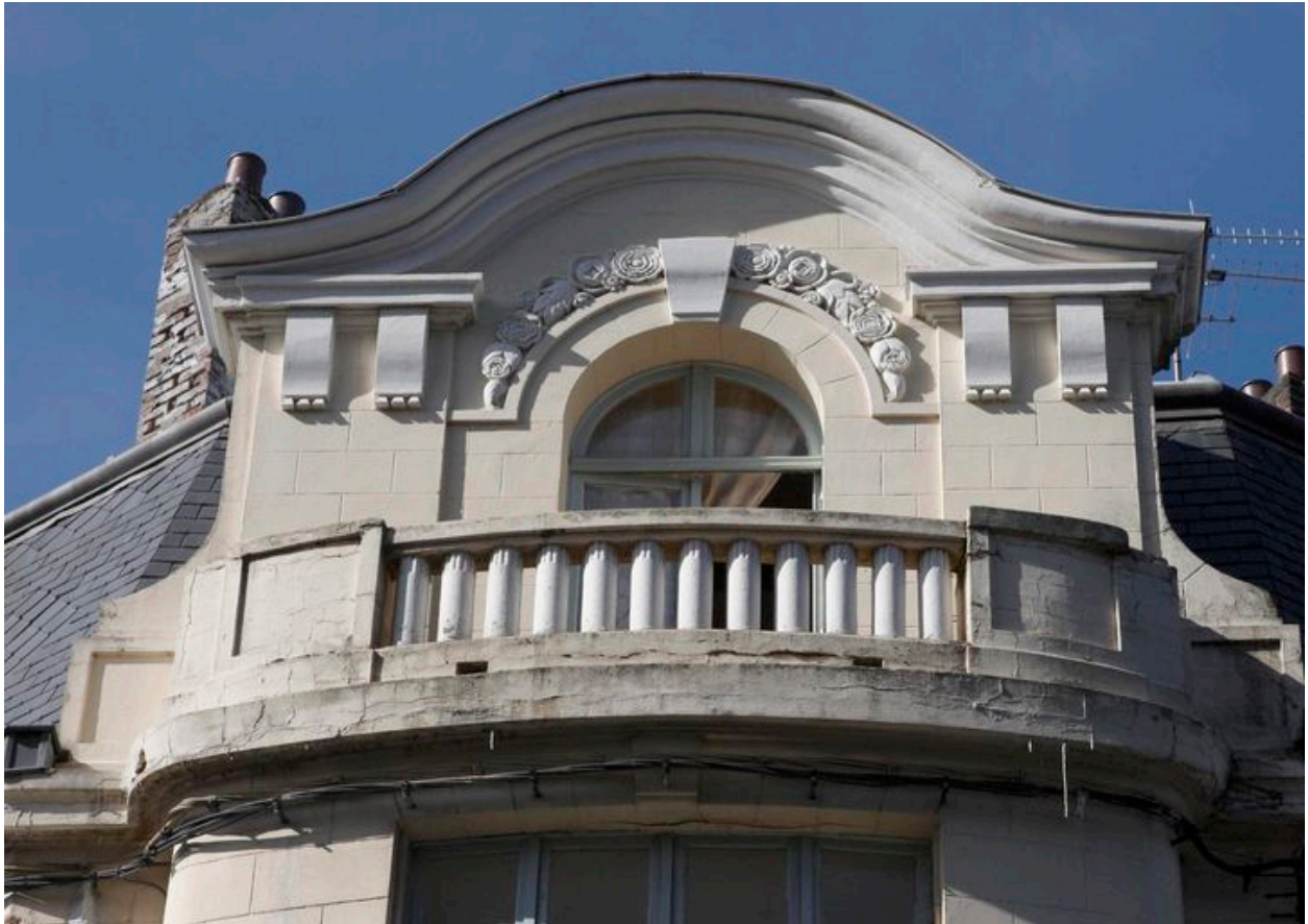
Détail du fronton orné d'une couronne de fleurs en aplat et d'agrafes aux extrémités géométriques.
