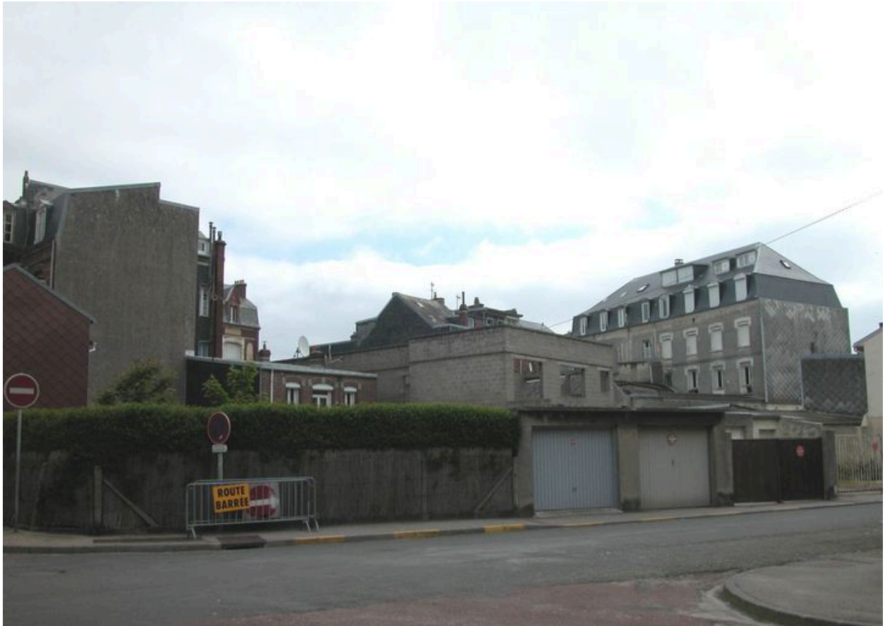
Dents creuses, rue Maurice-Dupont.
