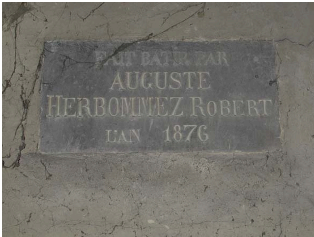
Cartouche commémoratif de construction.
