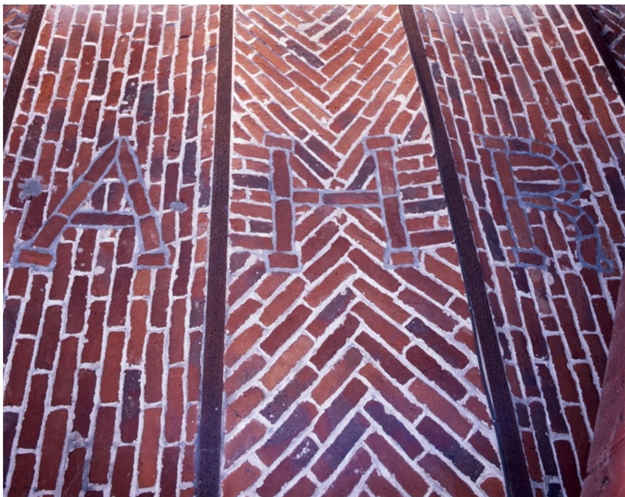
Les voûtes des écuries.
