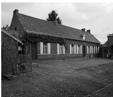
Vue générale du logis, 1036 rue de la Quièze. Phot. Philippe Dapvril IVR31_20055900964X
