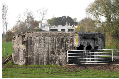
Elévation ouest Phot. Jean-Marc Ramette IVR31_20145904871NUCA
