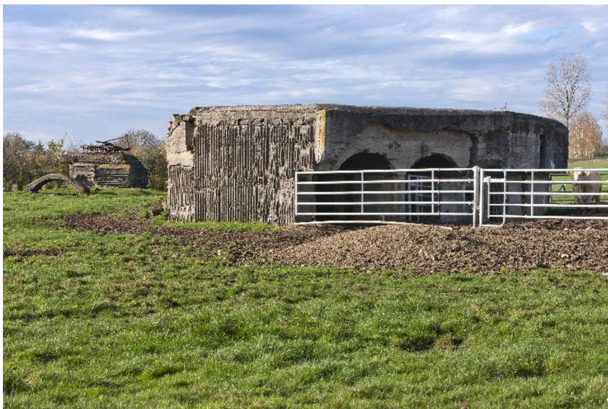
Vue de trois-quarts, vers le nord-est
