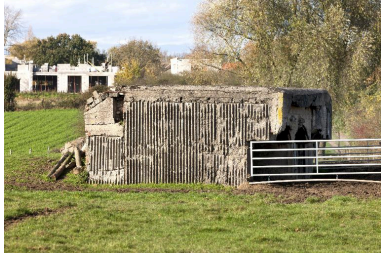
Elévation ouest Phot. Jean-Marc Ramette IVR31_20145904870NUCA
