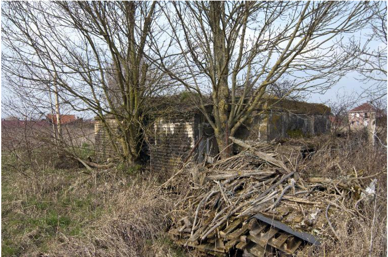
Vue de trois-quarts vers le nord
