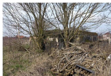
Vue de trois-quarts vers le nord Phot. Jean-Marc Ramette IVR31_20145905466NUCA
