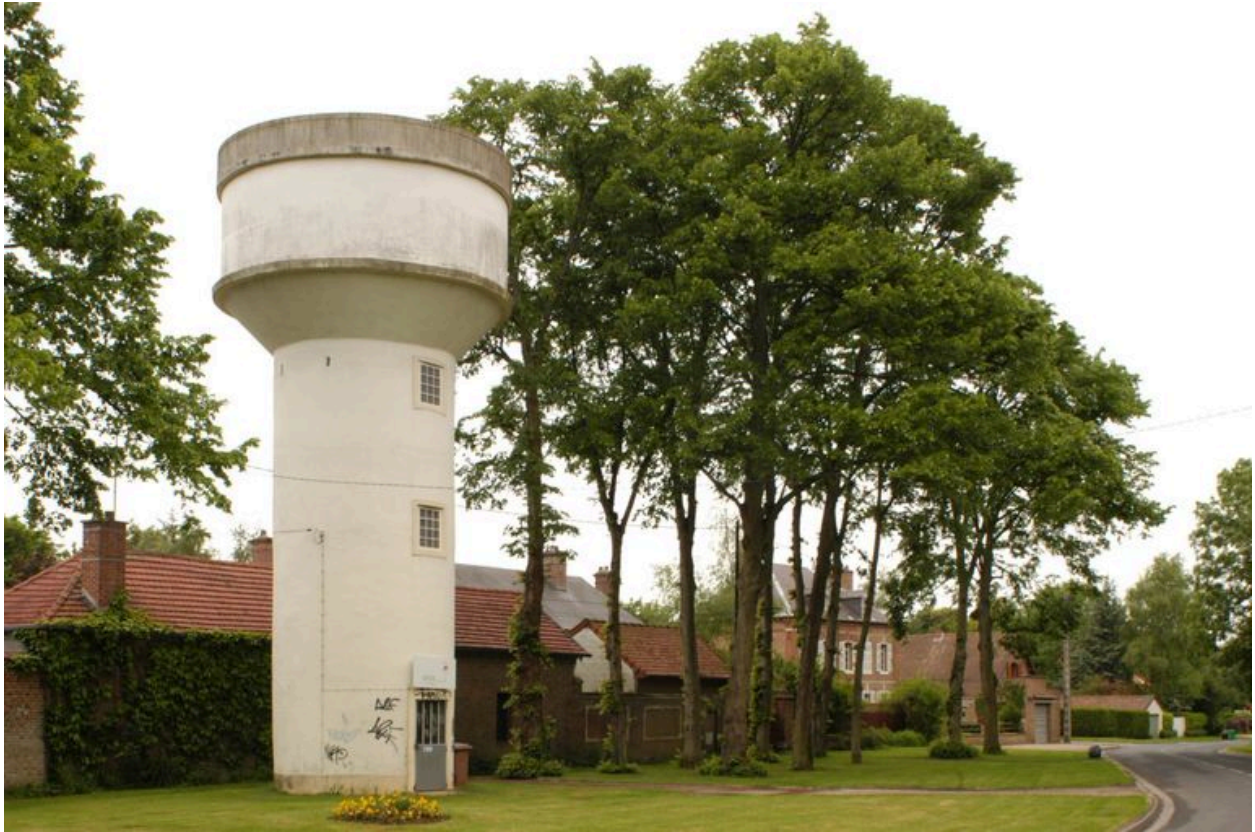
Le château d'eau.
