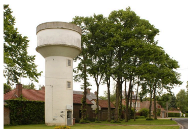
Le château d'eau. Phot. Thierry Lefébure IVR22_20038000426NUCA
