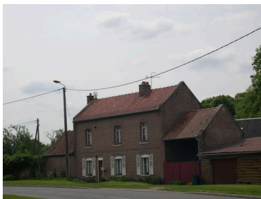
Maison, 12 rue de l'Eglise. Phot. Isabelle Barbedor IVR22_20038010369NUCA
