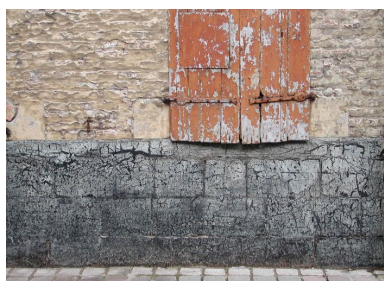
Façade du n° 11, vue partielle, état en 2006 : solin, volet, badigeon ocre.
