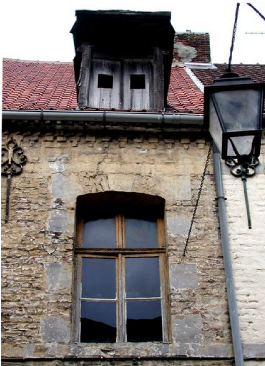
Façade du n° 11, vue partielle, état en 2006 : étage, corniche, comble, lucarne.
