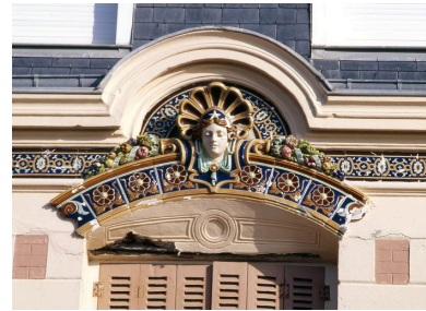
Détail du décor porté au-dessus de la baie. Phot. Marie-Laure Monnehay-Vulliet IVR22_20048000301XA
