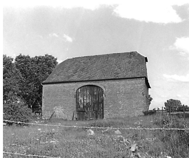
Grange traversante. Phot. Xavier-Philippe Guiochon IVR22_19980202358Z
