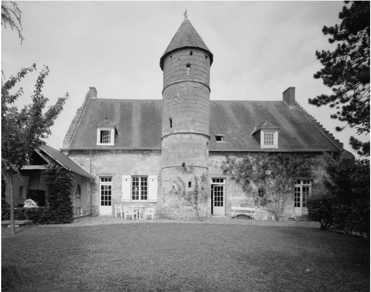
Logis. Elévation antérieure.
