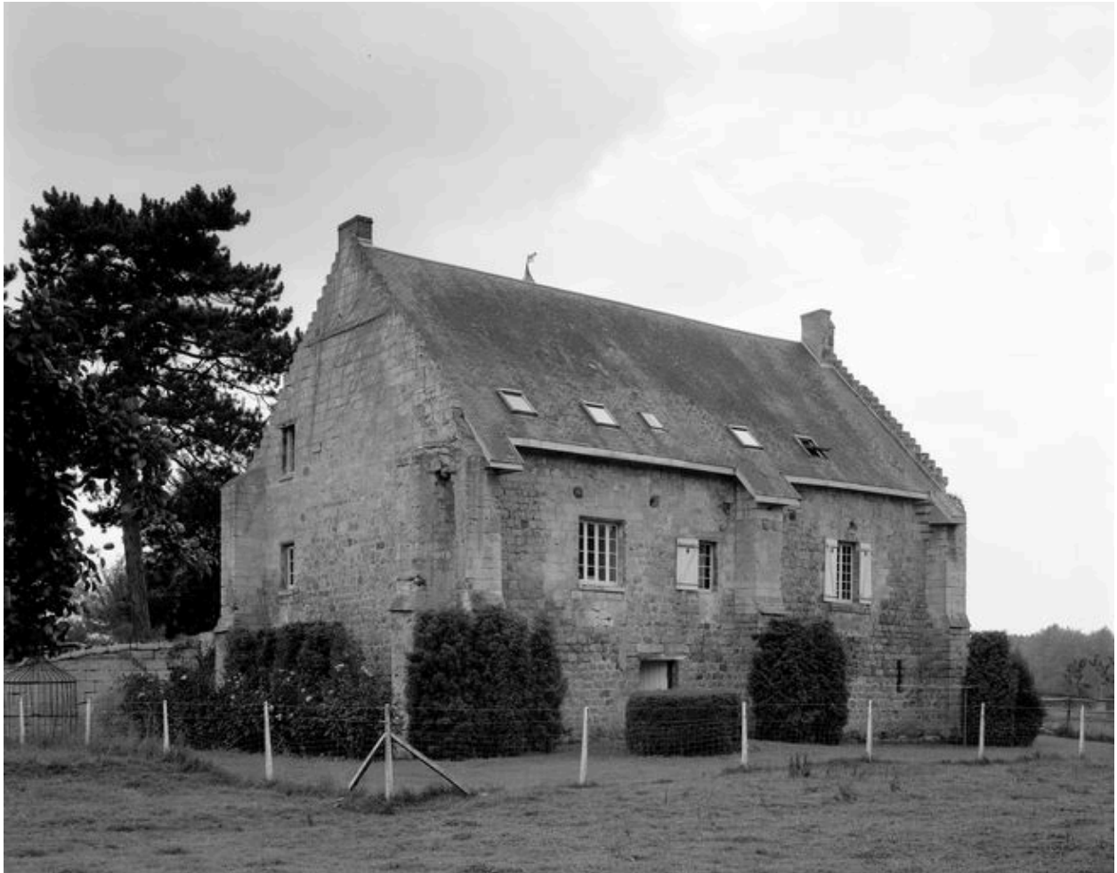
Logis. Elévation postérieure.
