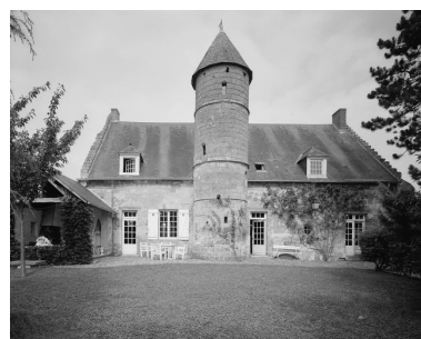
Logis. Elévation antérieure. Phot. Jean-Michel Perrin IVR22_19846001202V
