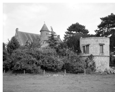
Vue générale. Phot. Jean-Michel Perrin IVR22_19846001180V
