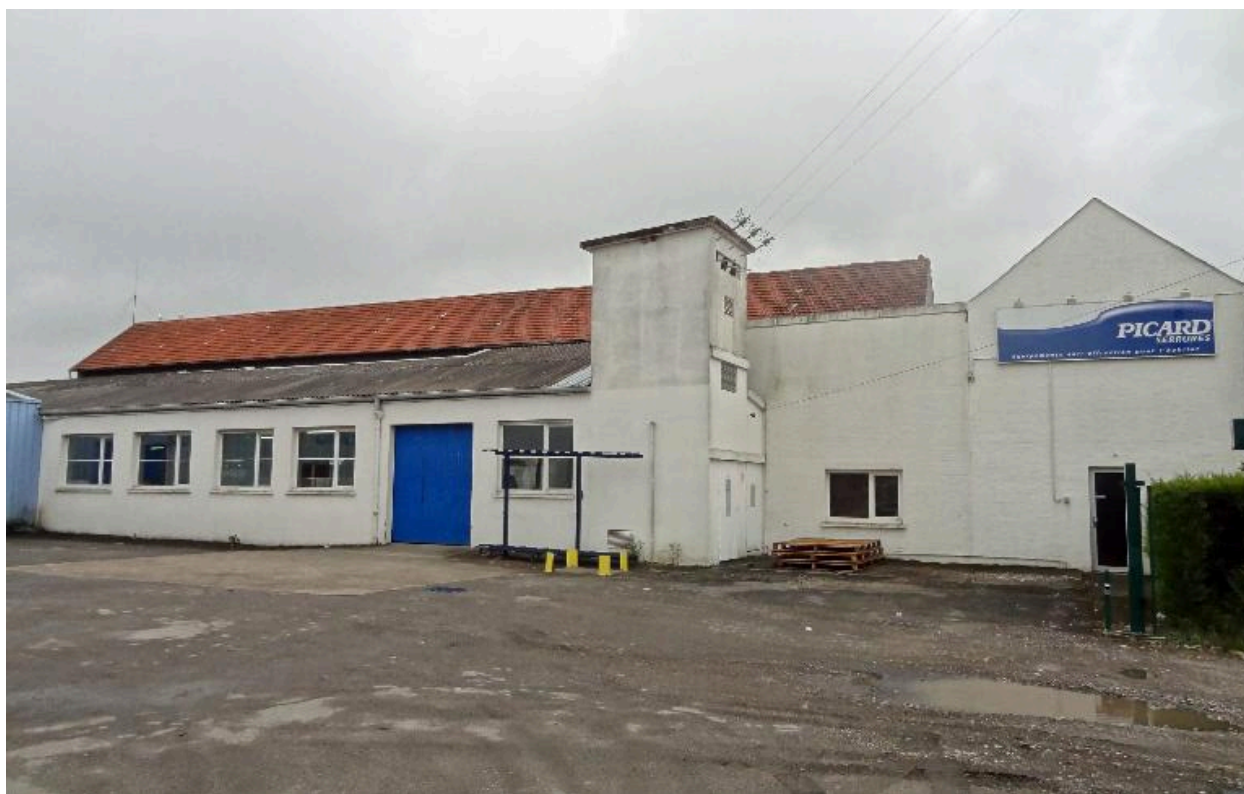
Vue générale des premiers bâtiments de l'usine.
