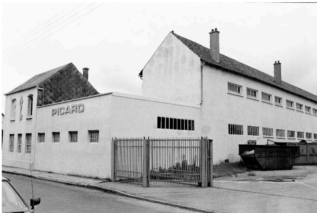
Vue générale depuis la rue Henri Basbusse; en 1990.
