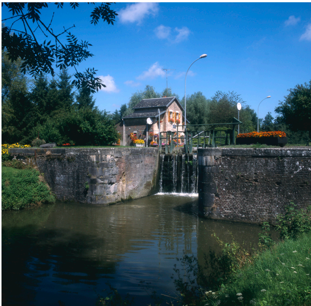
Vue de situation, depuis le canal.
