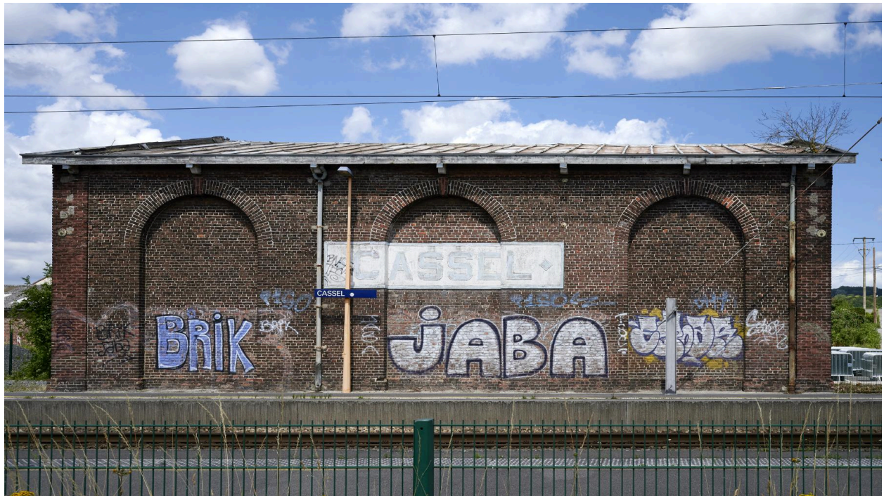
Façade sur voies.
