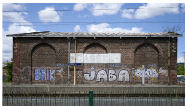
Façade sur voies. Phot. Delphine Volto Jourdan IVR32_20235901197NUCA
