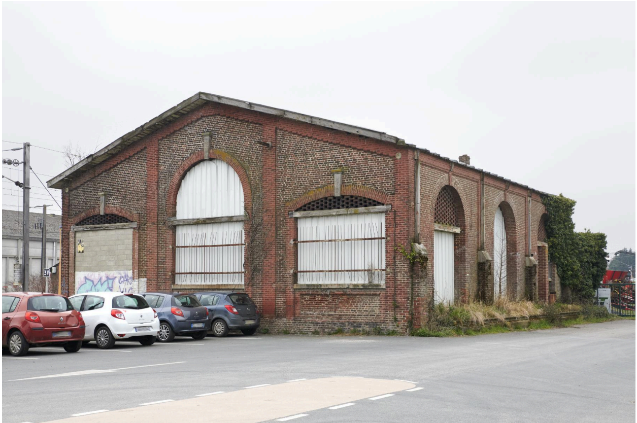
Vue de l'édifice depuis la cour.
