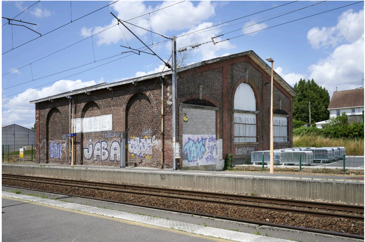
Vue générale depuis les voies.
