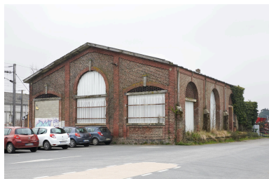
Vue de l'édifice depuis la cour. Phot. Delphine Volto Jourdan IVR32_20255900093NUCA
