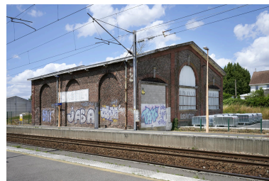
Vue générale depuis les voies. Phot. Delphine Volto Jourdan IVR32_20235901196NUCA
