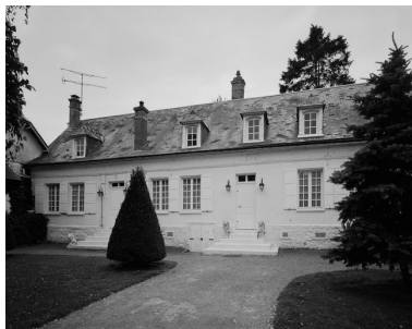
Elévation antérieure. Phot. Jean-Michel Périn IVR22_19846001113V
