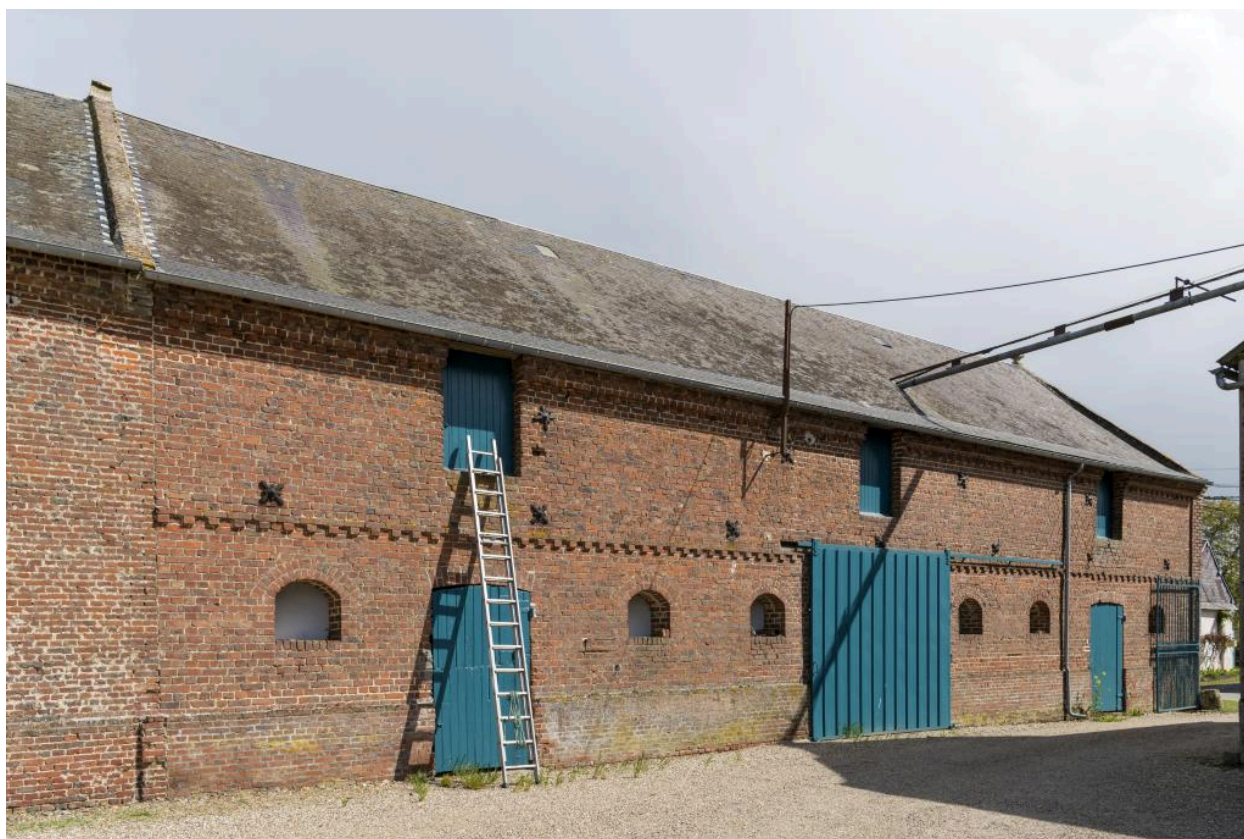
Ancienne bergerie, 2e moitié 19e siècle, vue depuis le nord-ouest.
