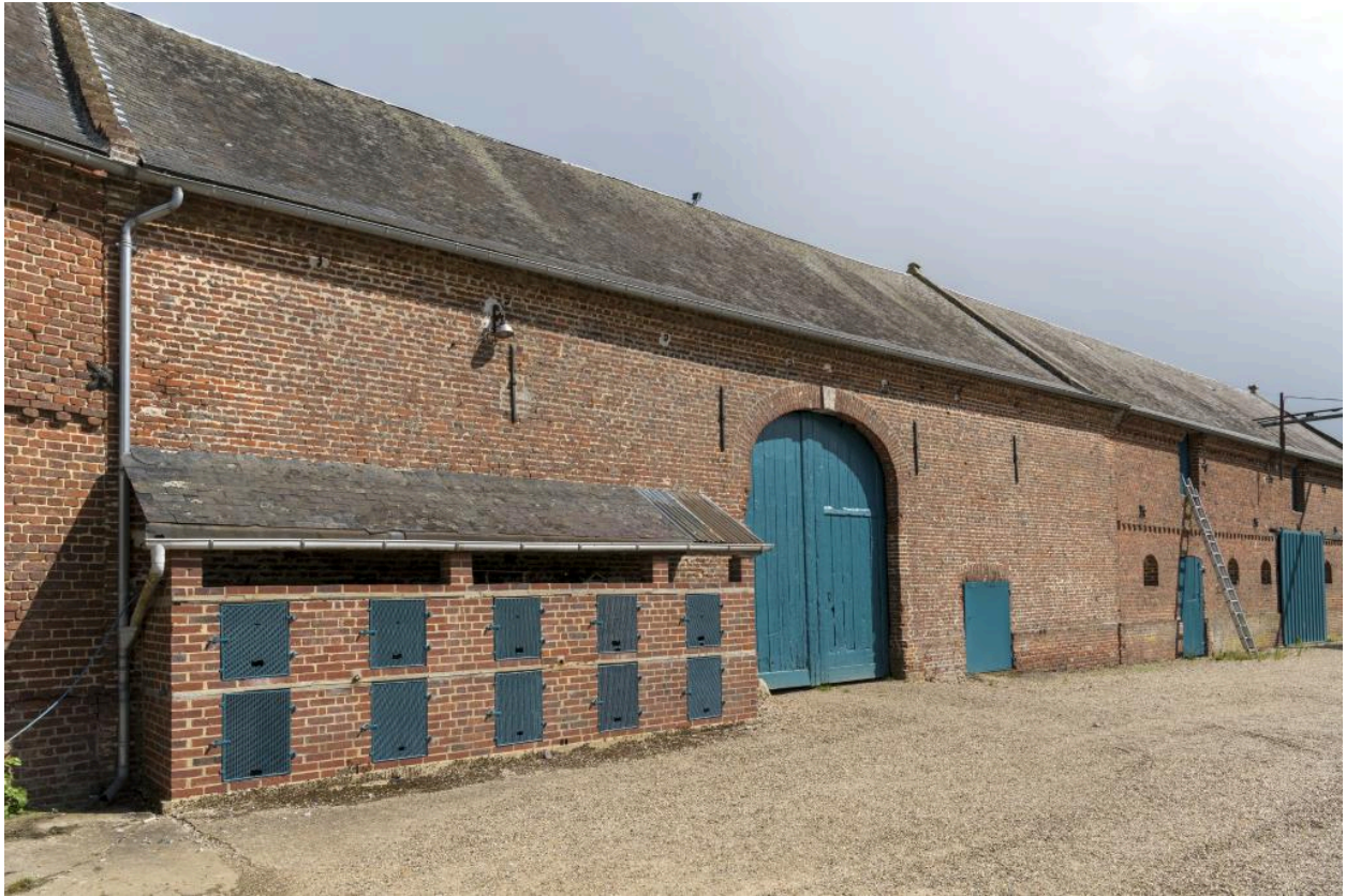
Grange et clapiers, 2e moitié 19e siècle, vue depuis le nord-ouest.
