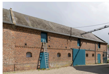
Ancienne bergerie, 2e moitié 19e siècle, vue depuis le nord-ouest. Phot. Marc Kérignard IVR32_20216000433NUCA
