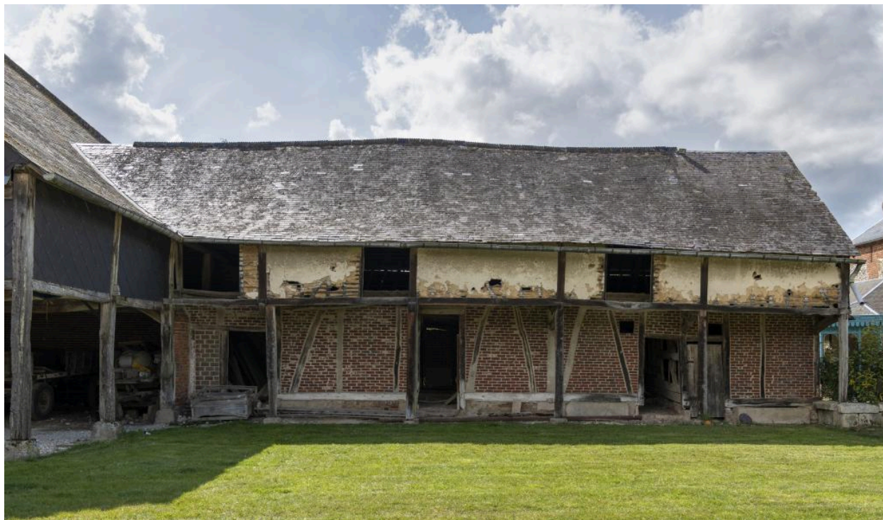
Ancien pressoir (à gauche) et porcheries, vue depuis l'est.
