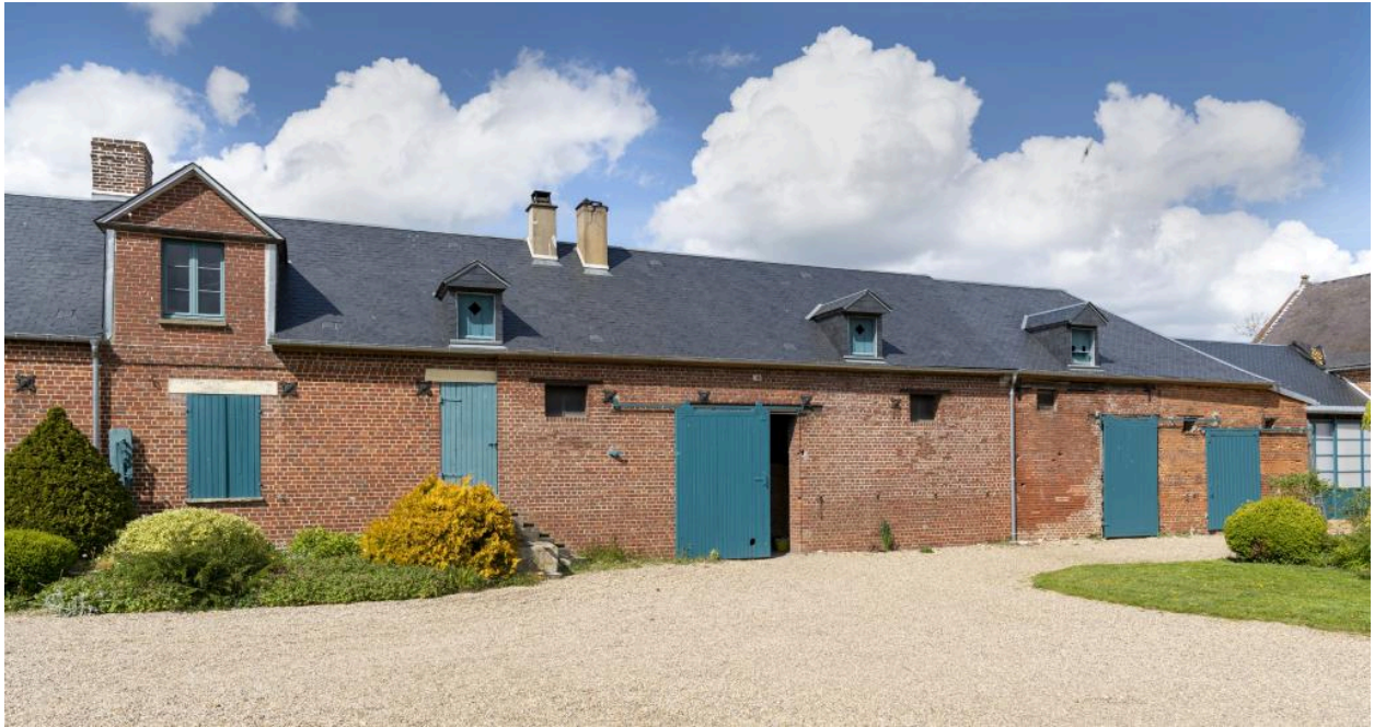
Anciens ateliers agricoles et écuries, vers 1907, vue depuis le sud.
