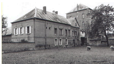
Le logement de 1869 et la minoterie à l'arrière plan, façade postérieure. Phot. Thierry Lefébure IVR22_20026001008X
