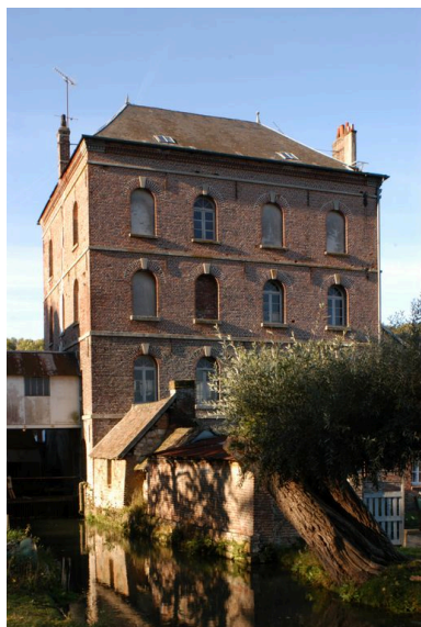
Façade nord-ouest de la minoterie portant la date de 1858. Phot. Thierry Lefébure IVR22_20036000593NUCA
