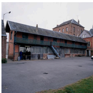
Atelier de fabrication, en retour du logement de 1869, façade sur cour.
