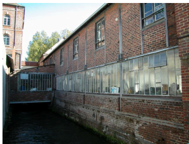
Le canal de fuite et détail du mur est de l'atelier de fabrication. Phot. Thierry Lefébure IVR22_20036000599NUCA
