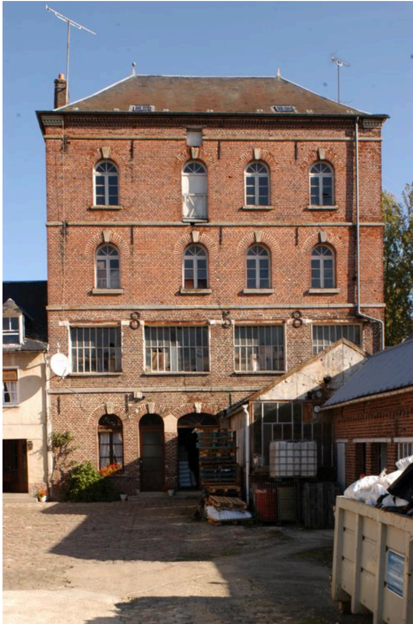
Façade sud-est de la minoterie portant la date de 1858.
