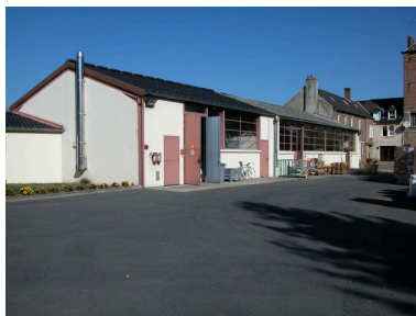
Atelier de fabrication construit en 1965. Phot. Thierry Lefébure IVR22_20036000600NUCA
