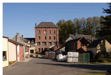
Vue d'ensemble de la minoterie. Phot. Thierry Lefébure IVR22_20036000590NUCA
