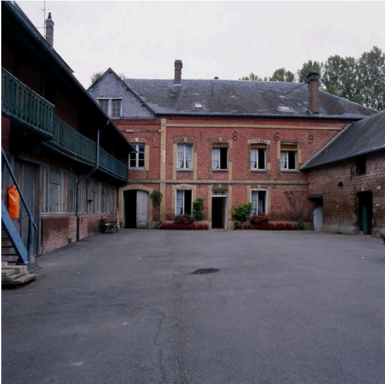
Le logement construit en 1869, façade sur cour.
