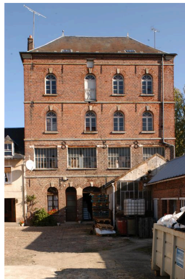
Façade sud-est de la minoterie portant la date de 1858. Phot. Thierry Lefébure IVR22_20036000592NUCA
