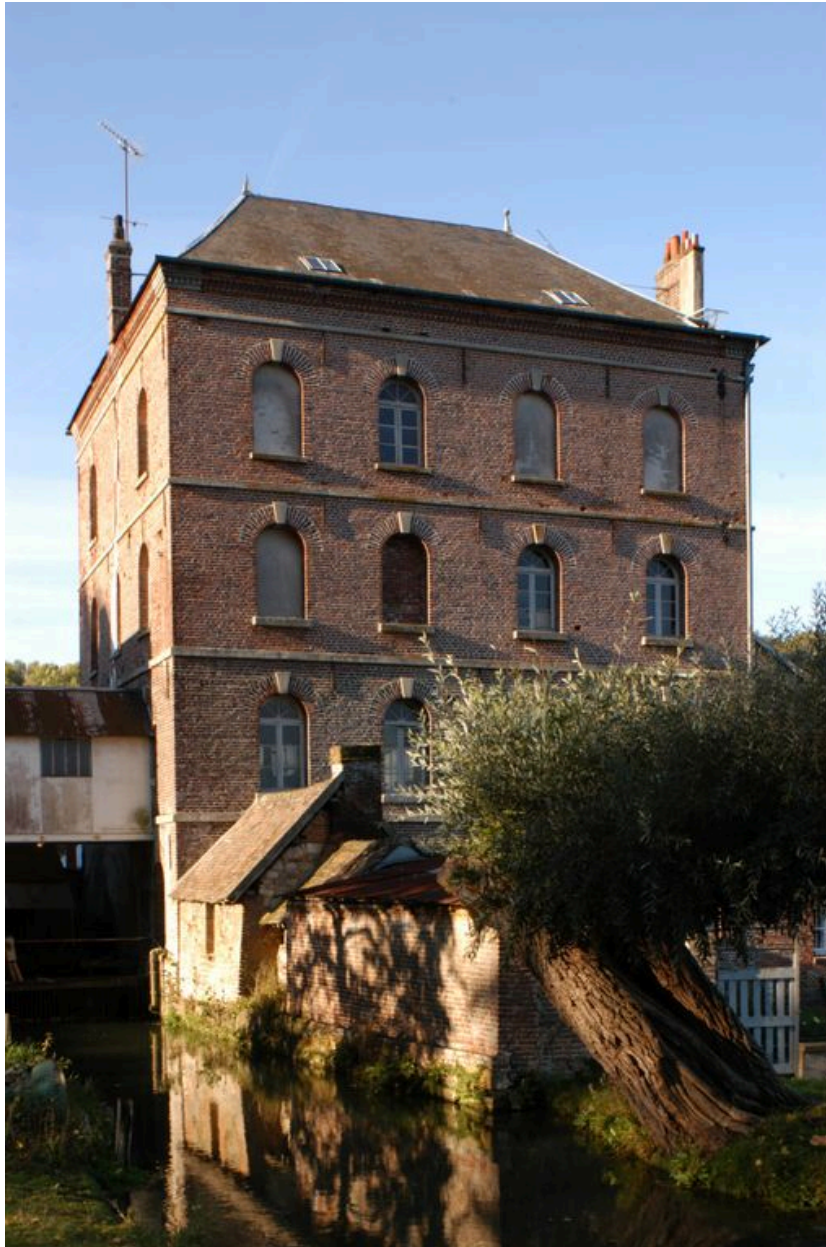
Façade nord-ouest de la minoterie portant la date de 1858.
