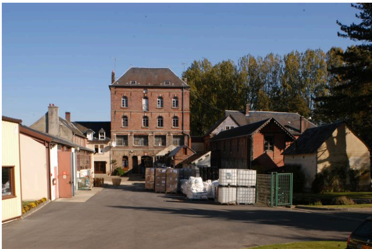
Vue d'ensemble de la minoterie.
