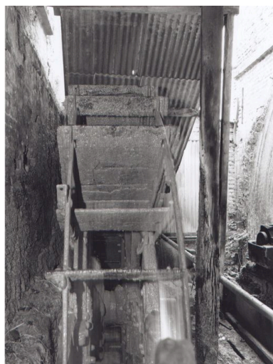
Détail de la roue hydraulique verticale encore en place.
