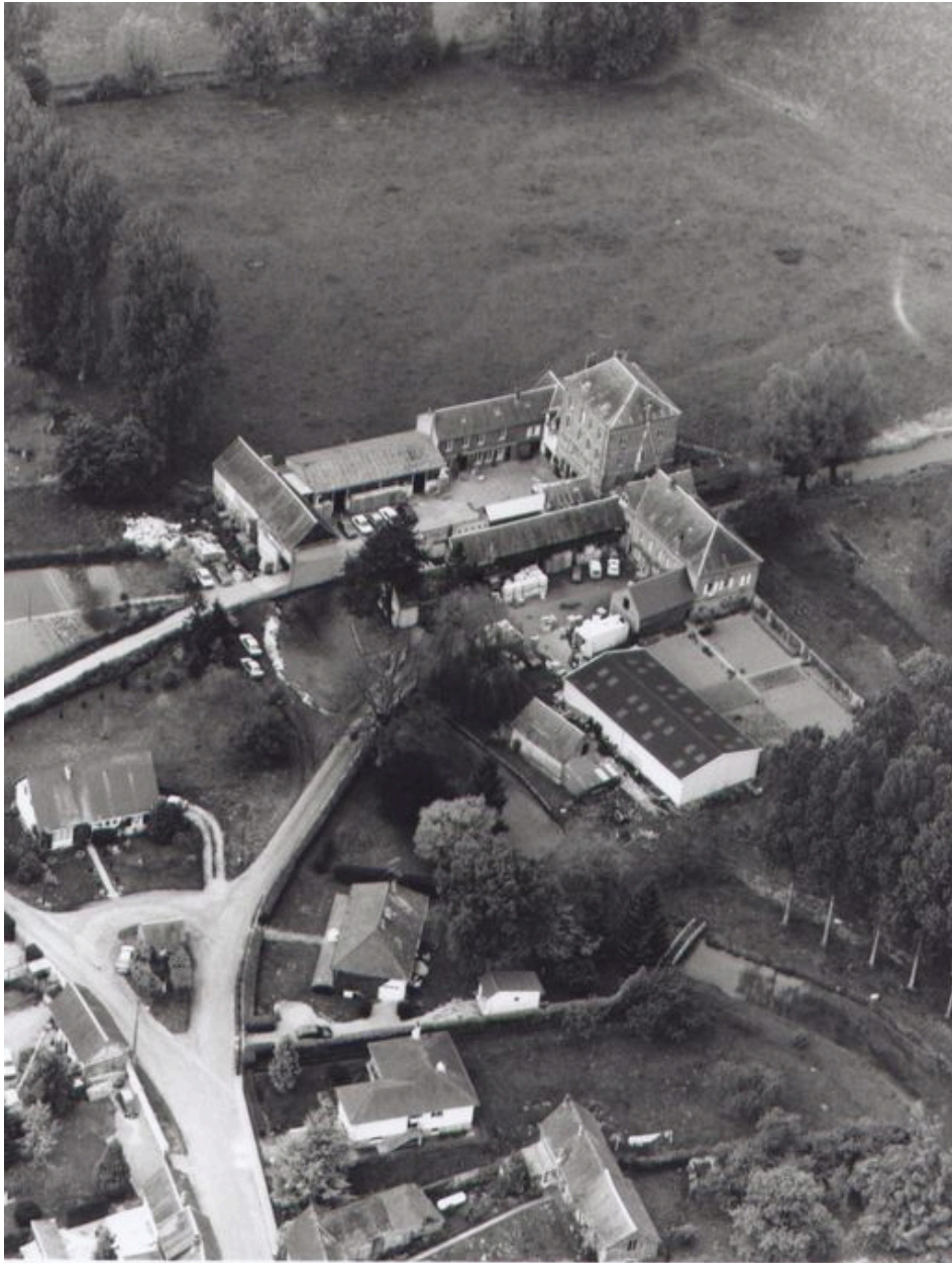
Vue aérienne de l'usine en 1994.
