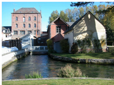
Vue d'ensemble sud de la minoterie et du canal de fuite. Phot. Thierry Lefébure IVR22_20036000598NUCA
