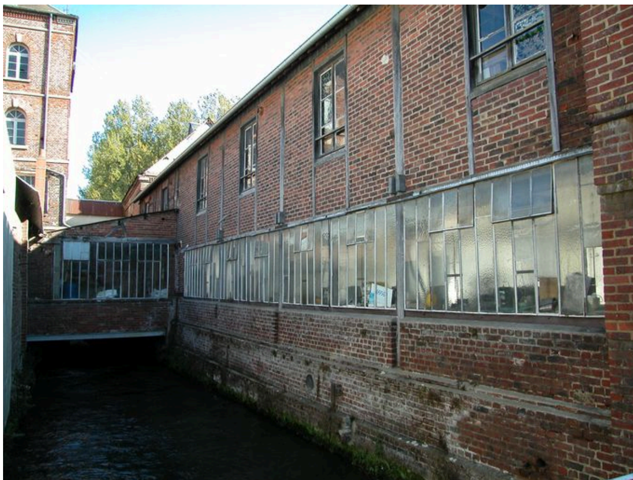
Le canal de fuite et détail du mur est de l'atelier de fabrication.
