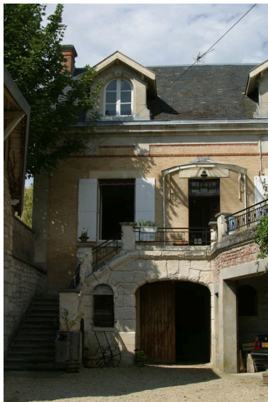
Vue d'ensemble. Phot. Irwin Leullier IVR22_20050200848NUCA
