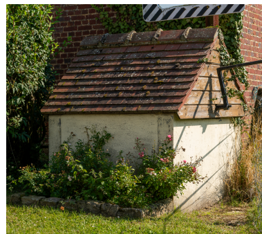
Puits réhabilité à côté du n°1 de la rue de la Folie, vue depuis le nord-ouest. Phot. Marc Kérignard IVR32_20246000951NUCA
