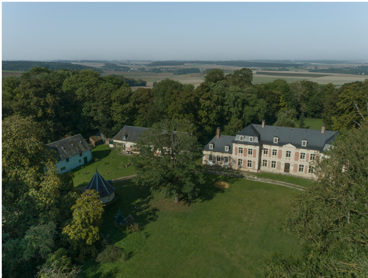
Vue aérienne du château de Beauvoir depuis le sud-est.
