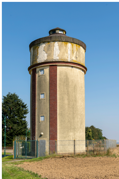
Château d'eau, sortie sud du village. Phot. Marc Kérignard IVR32_20246000949NUCA
