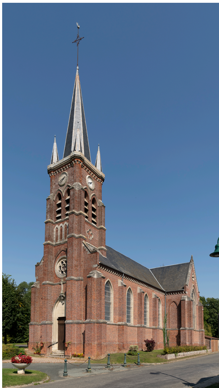
Église Saint-Denis, vue depuis le sud-ouest.
