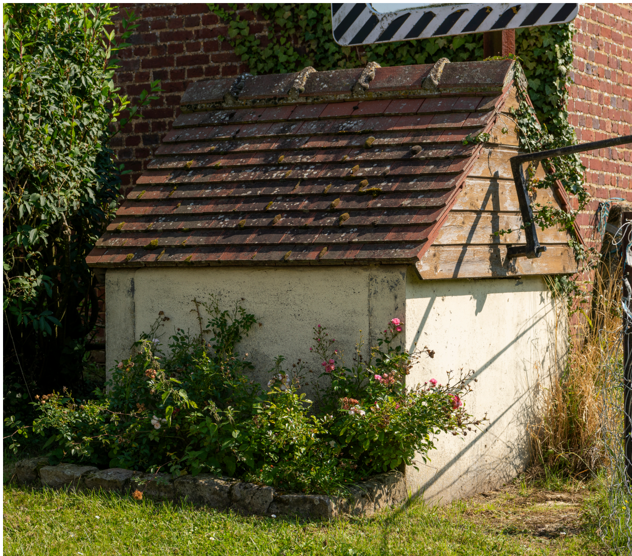
Puits réhabilité à côté du n°1 de la rue de la Folie, vue depuis le nord-ouest.
