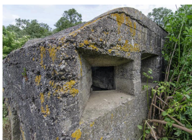
Ouvertures sur le pignon sud-est (au grand angulaire) Phot. Jean-Marc Ramette IVR32_20165901149NUCA
