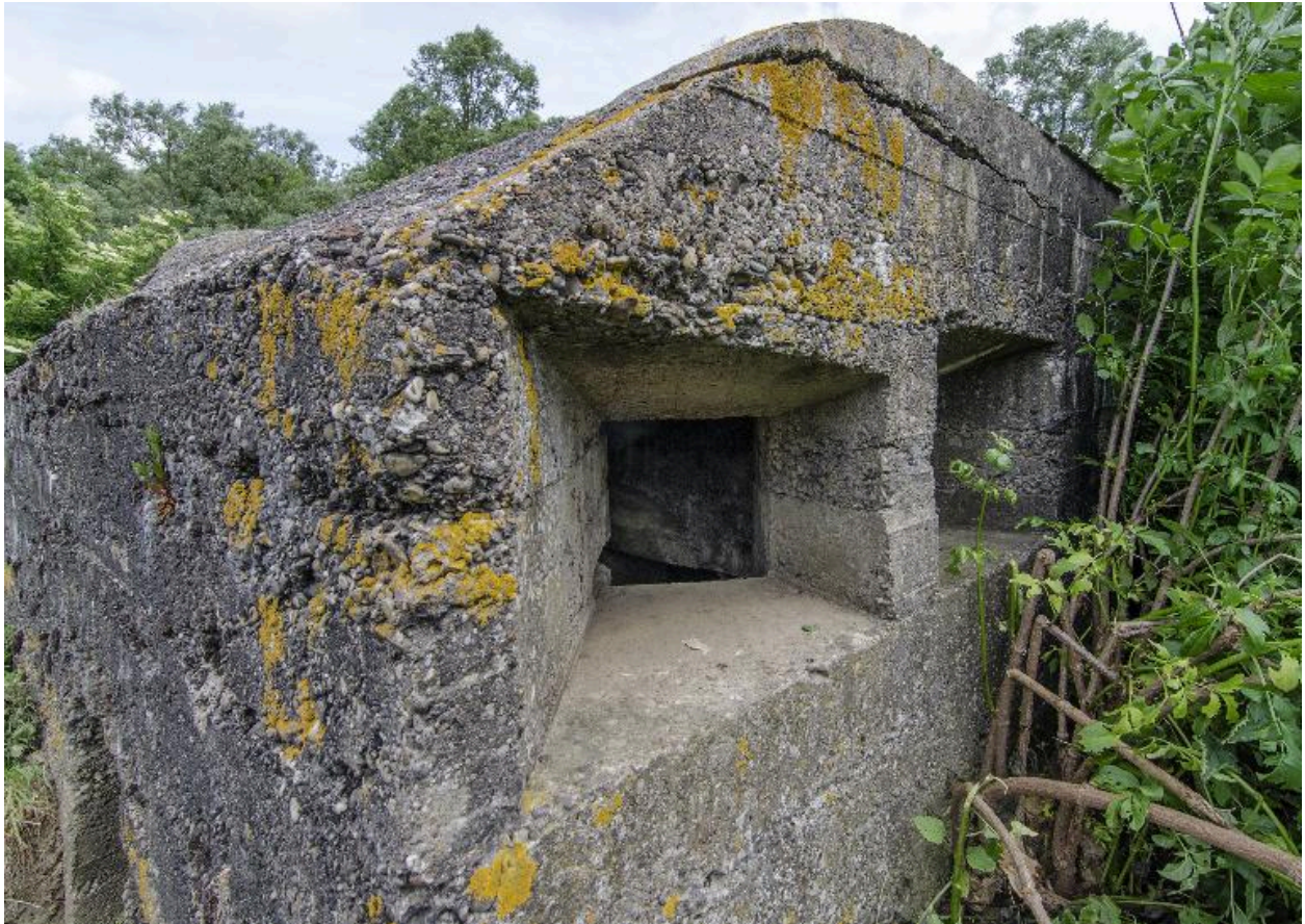
Ouvertures sur le pignon sud-est (au grand angulaire)
