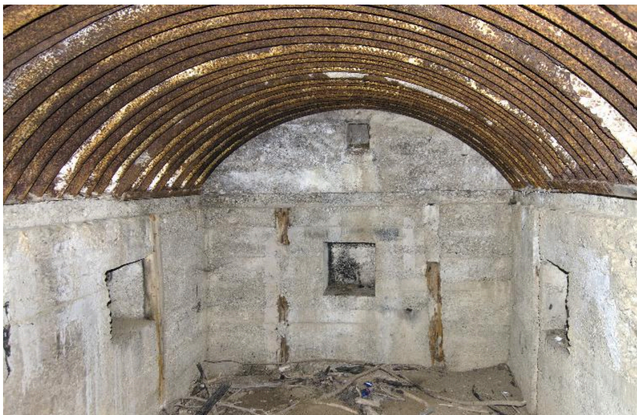
Abri à personnel, vue intérieure, pignon nord-ouest (au grand angulaire)
