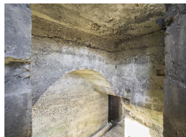
Sortie du poste d'observation vers le couloir de distribution (au grand angulaire) Phot. Pierre Thibaut IVR32_20165900048NUCA
