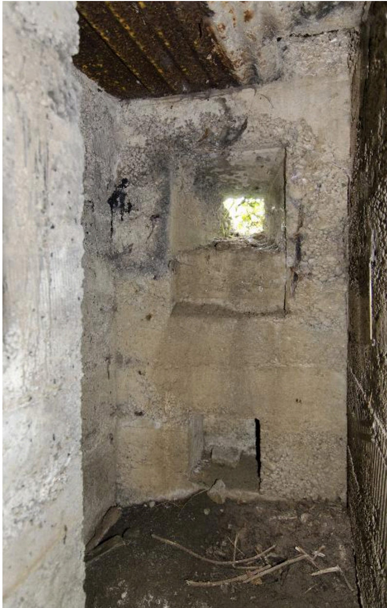
Créneau de fusillade vers le sud-ouest
