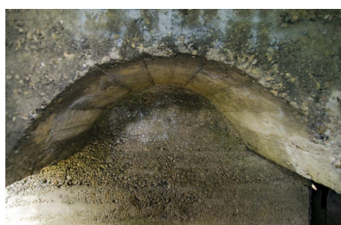
Sortie du poste d'observation. Voûte transversale, au couloir de distribution (au grand angulaire) Phot. Jean-Marc Ramette IVR32_20165901154NUCA
