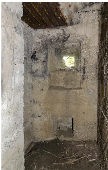
Créneau de fusillade vers le sud-ouest Phot. Jean-Marc Ramette IVR32_20165901159NUCA
