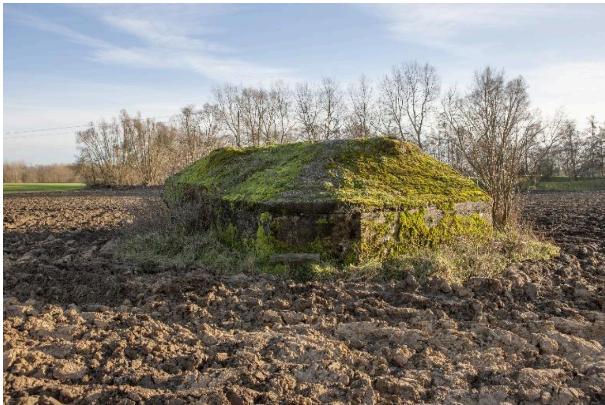
Vue de trois-quarts vers le sud.
