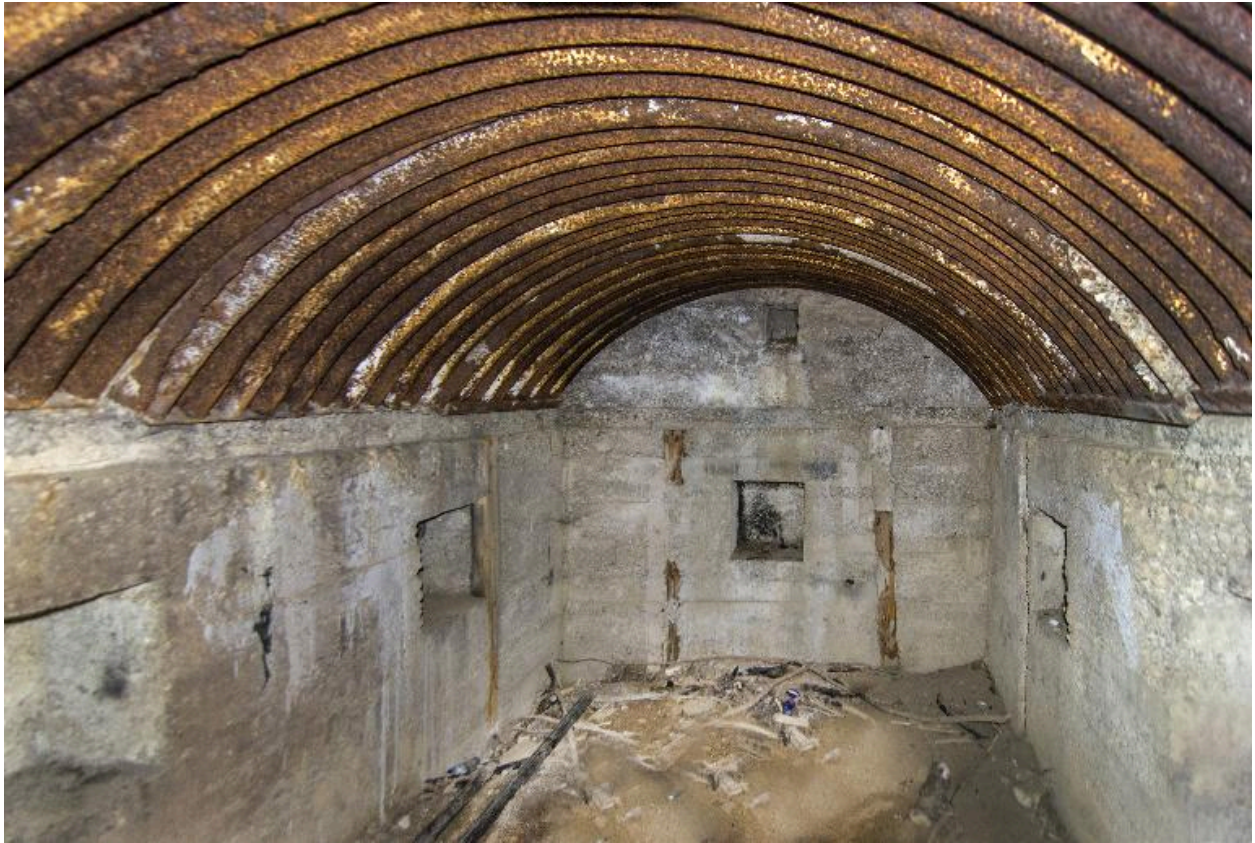
Abri à personnel. Vue intérieure (au grand angulaire)
