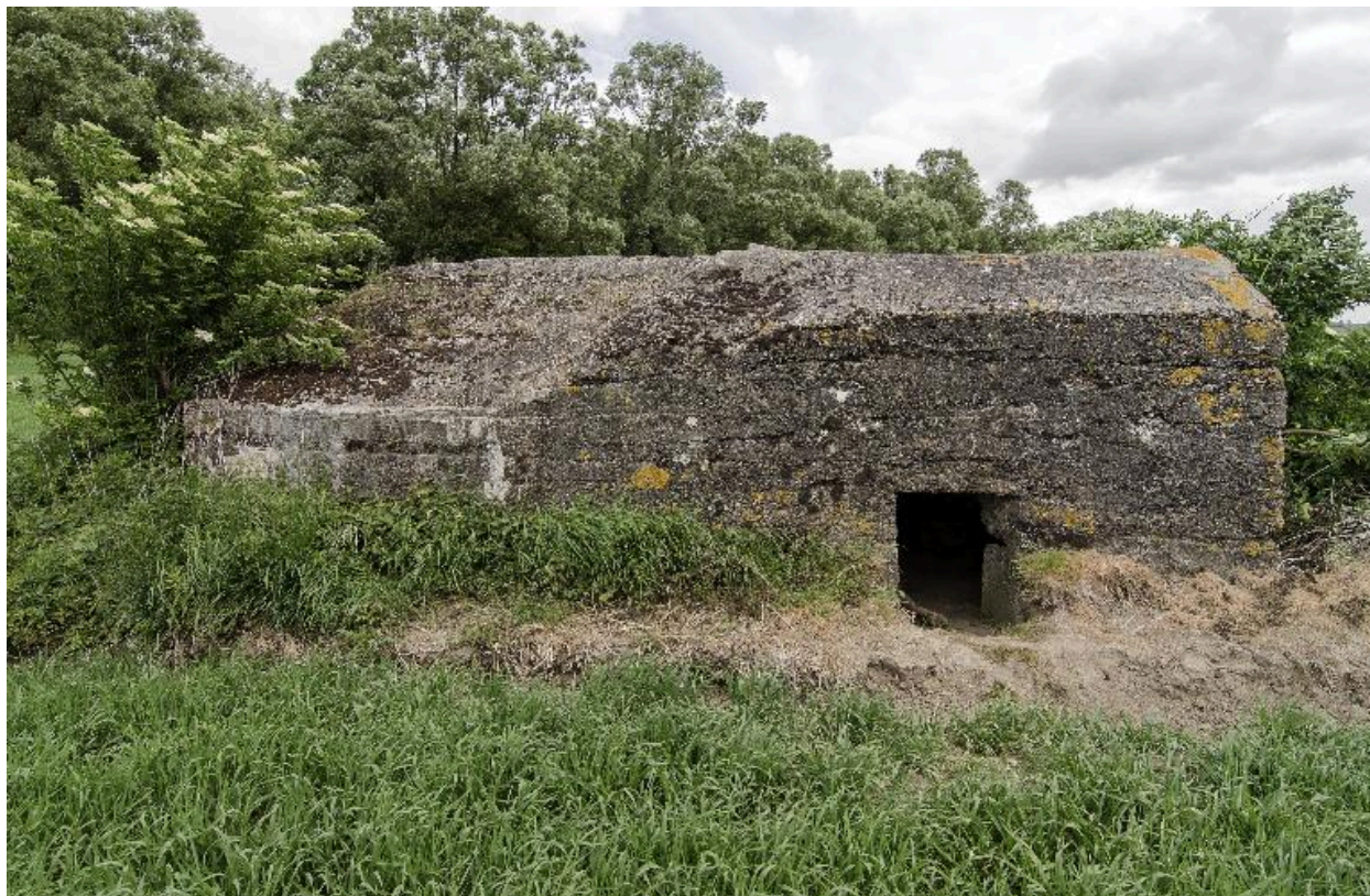
Vue latérale vers le nord-est. Entrée
