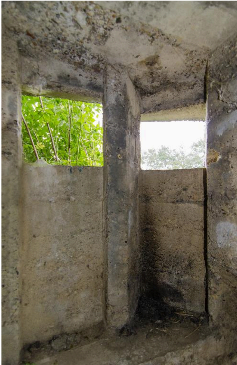
Intérieur du poste d'observation (au grand angulaire)
