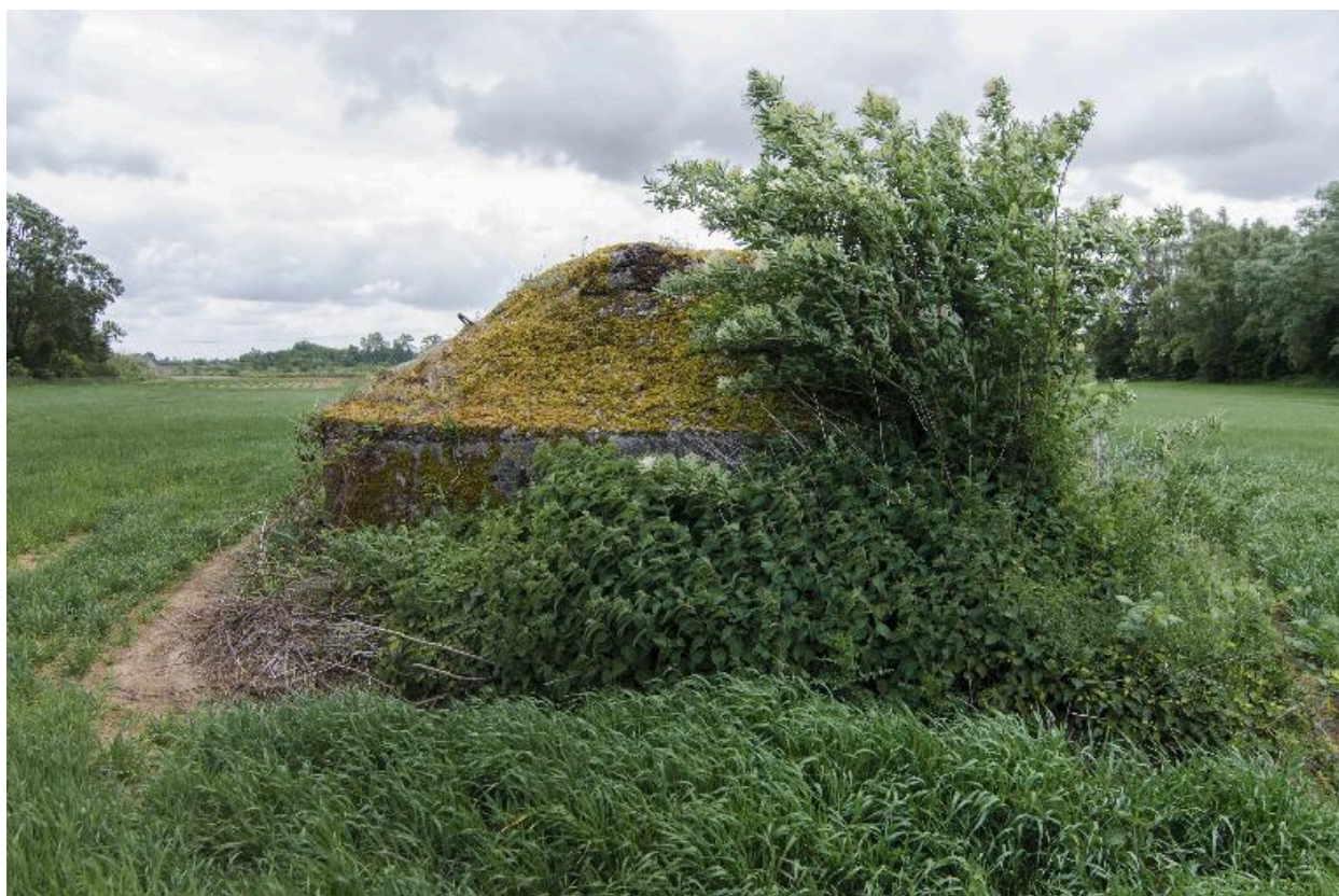
Vue générale vers le nord-ouest
