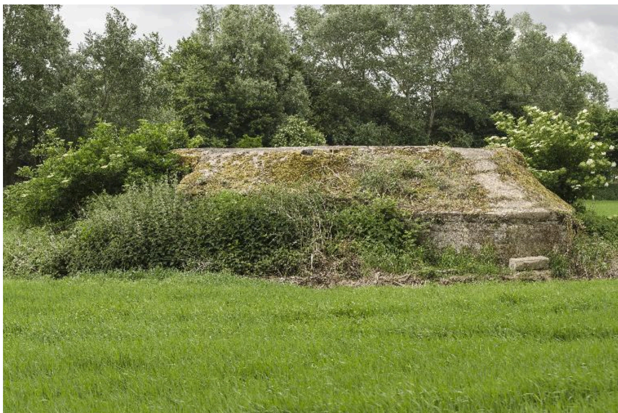
Vue latérale vers le sud-ouest
