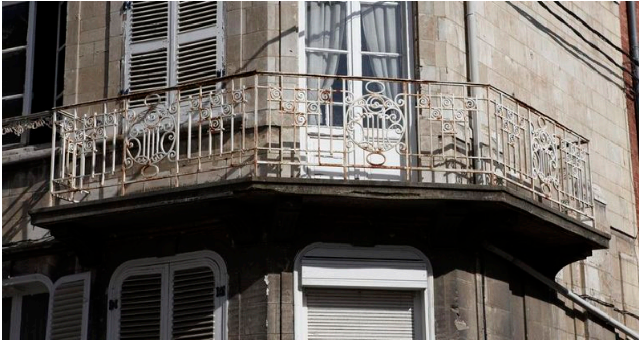
Ferronnerie Art déco du balcon situé à l'angle.
