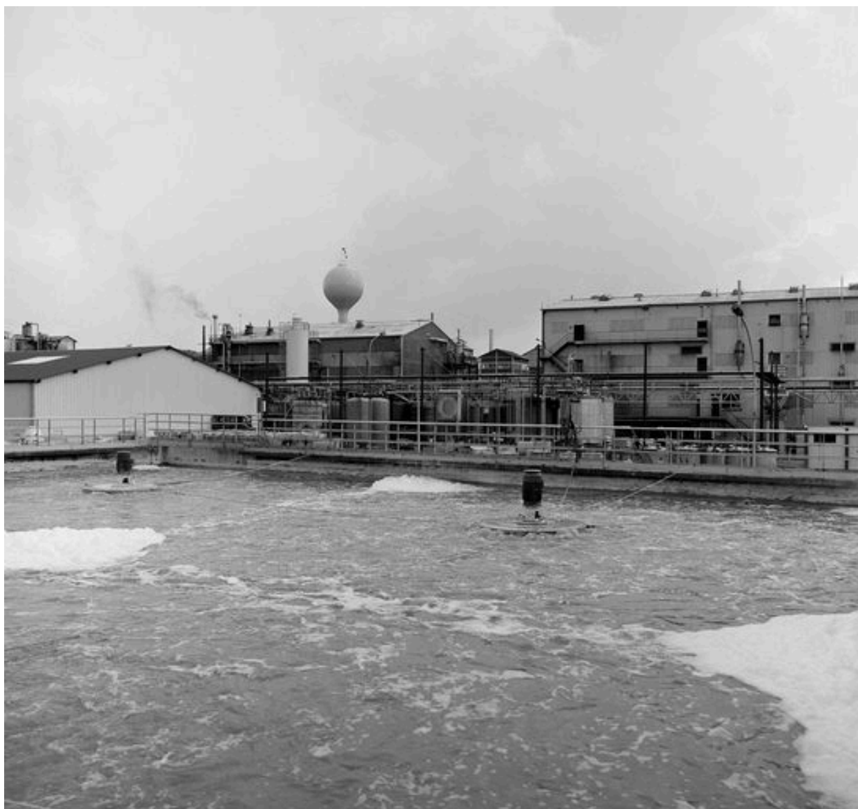
La station d'épuration construite vers 1970.
