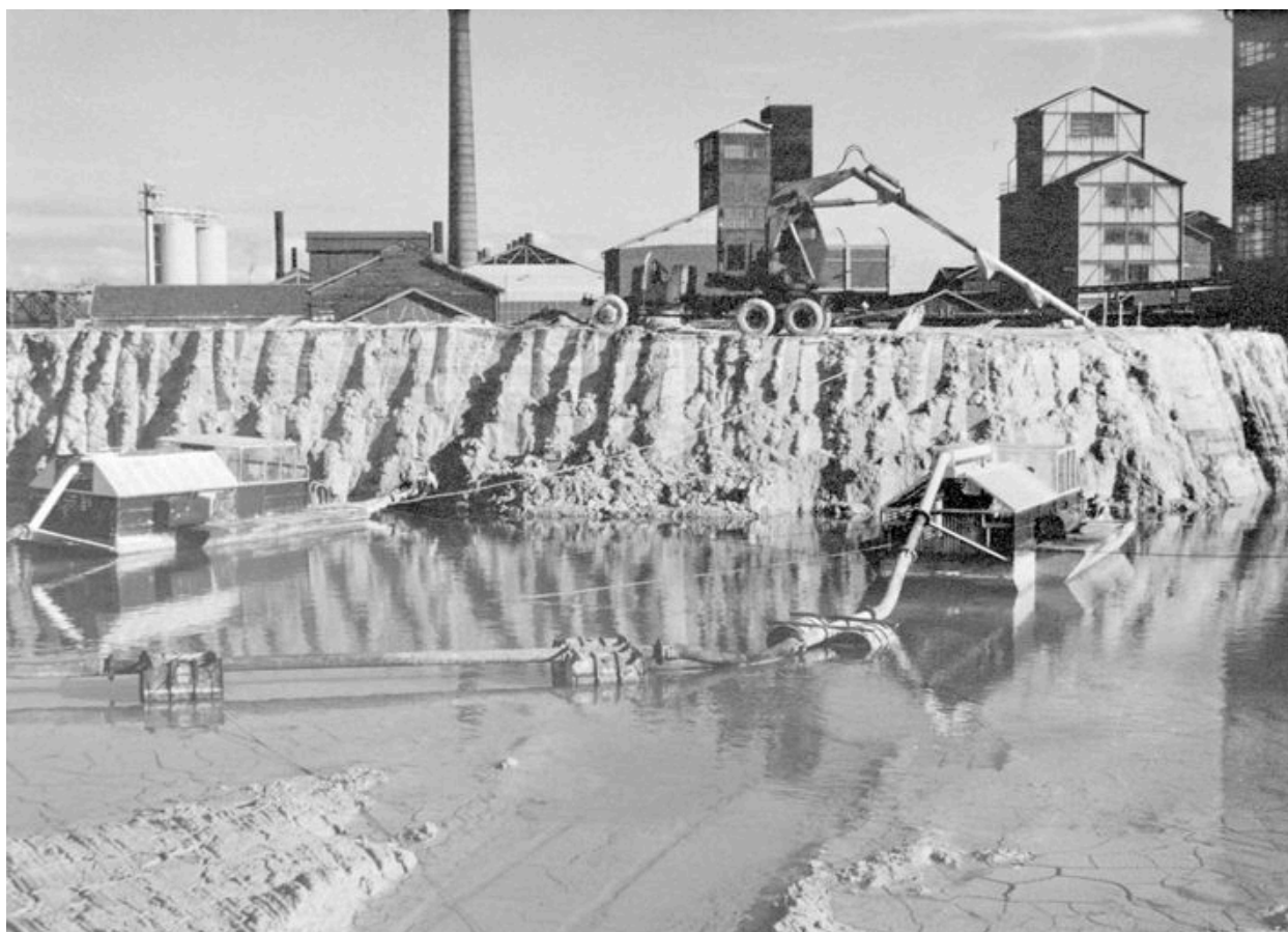
Travaux de terrassement (AP).
