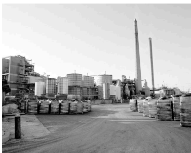
Réservoirs industriels. Phot. Thierry Lefébure IVR22_19926000341X
