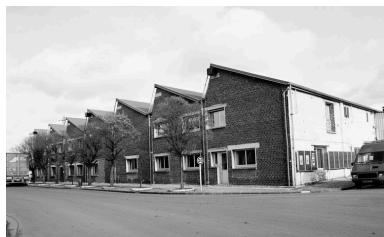
Ateliers de fabrication avec sheds construits vers 1925. Phot. Thierry Lefébure IVR22_19926000361X
