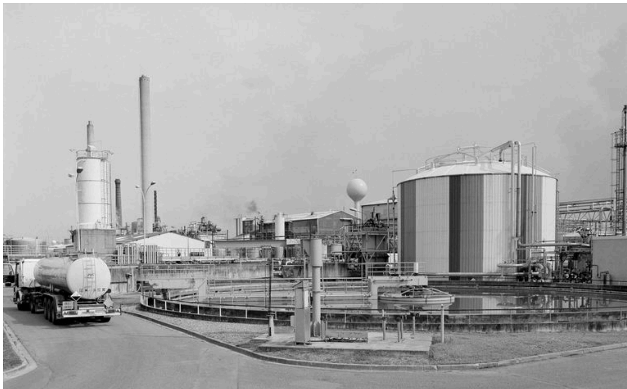
La station d'épuration construite vers 1970.
