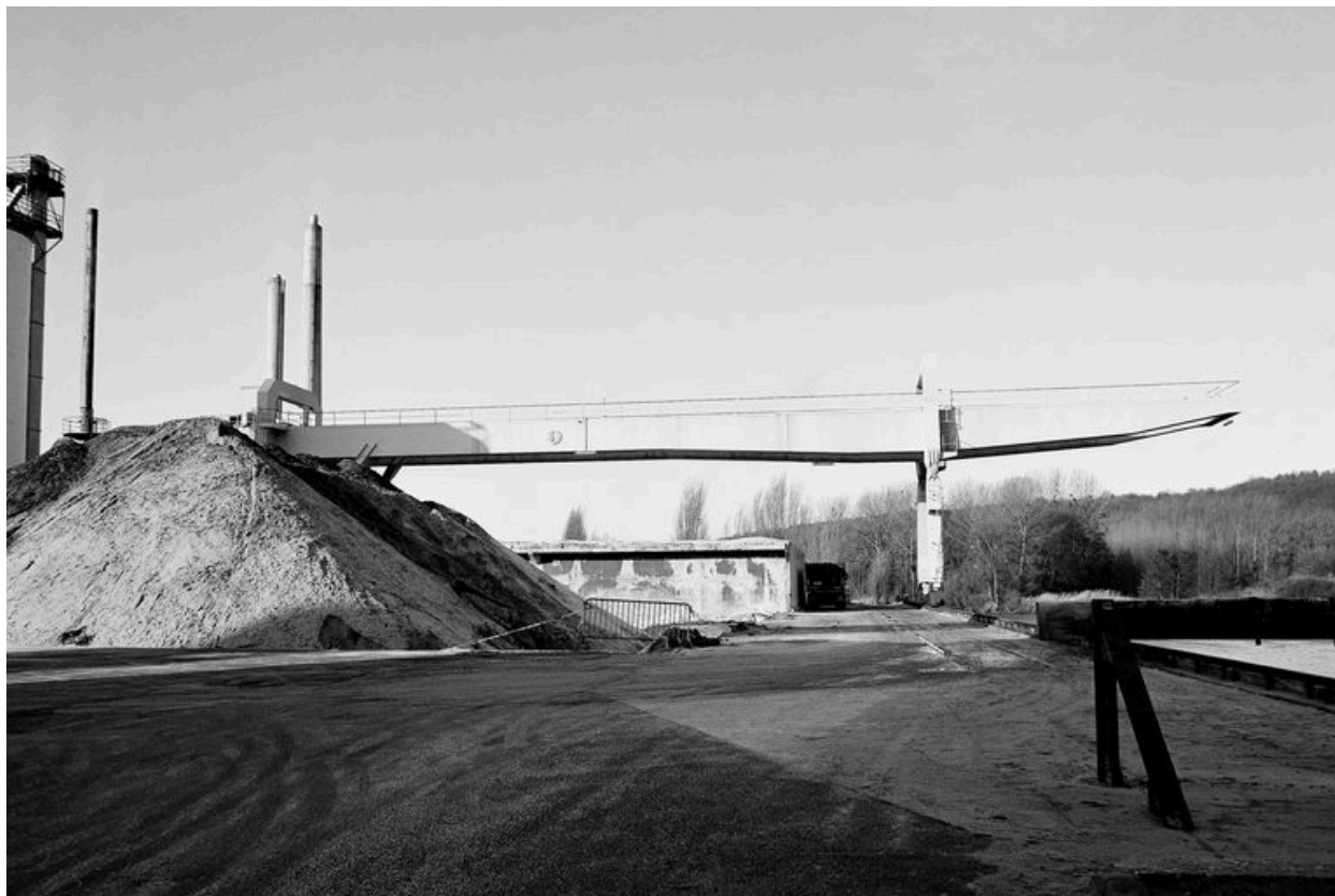
Aire de débarquement des matières premières et pont roulant.
