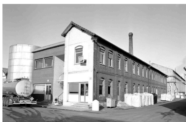
Atelier de fabrication : élévation est. Phot. Thierry Lefébure IVR22_19926000362X
