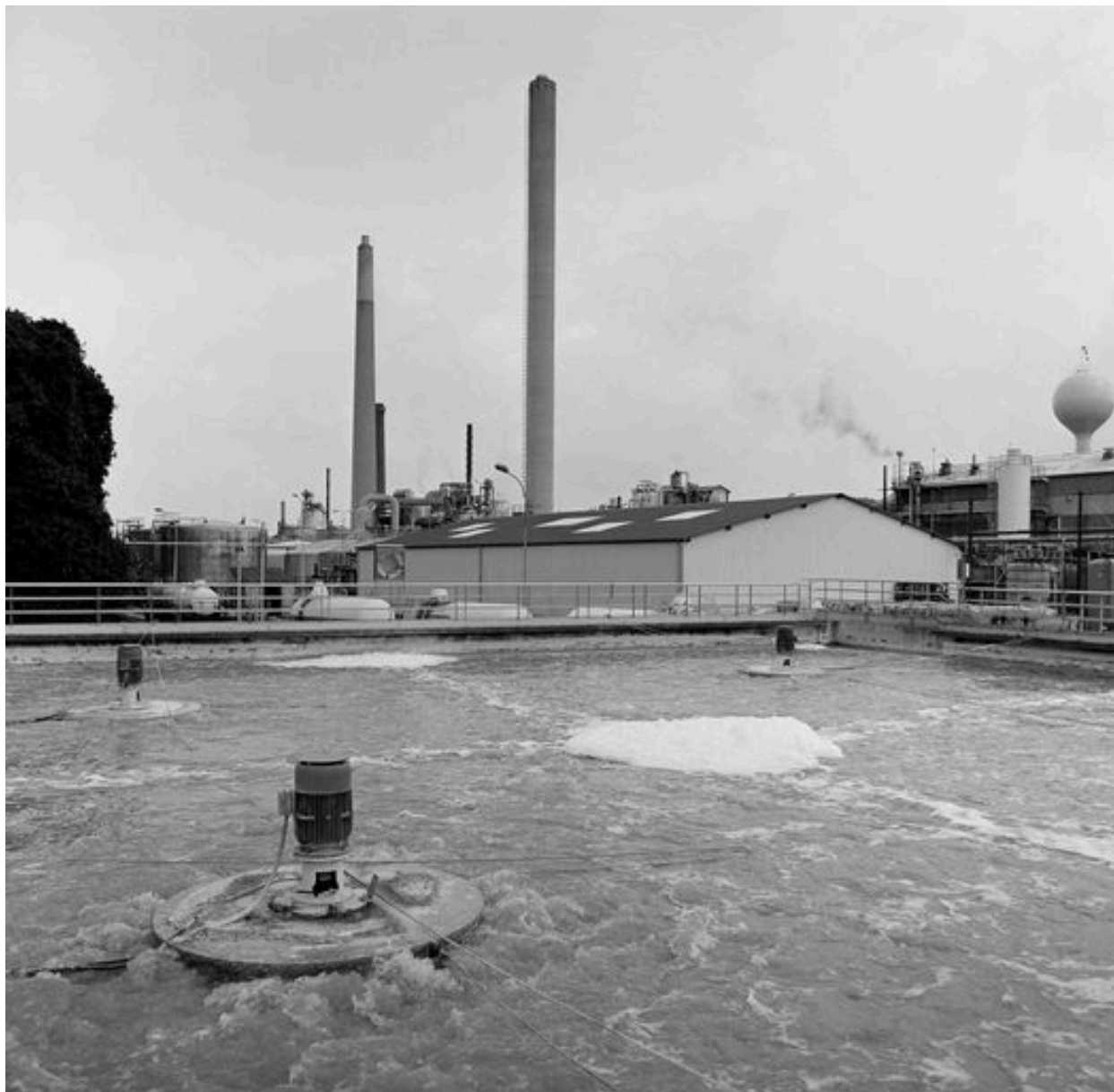
La station d'épuration construite vers 1970.
