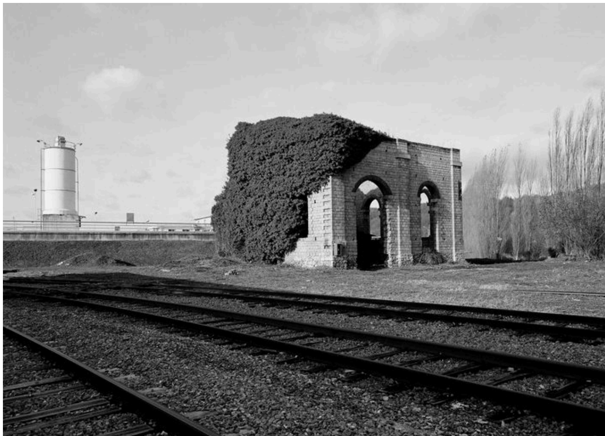
Ancien atelier de fabrication de la savonnerie.
