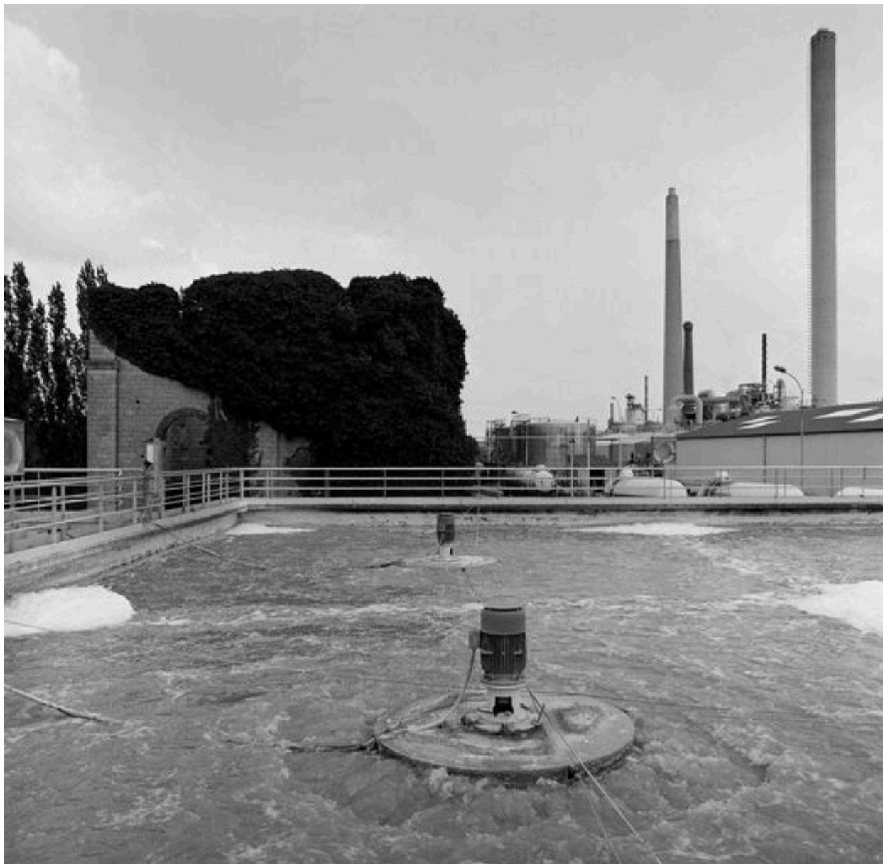
La station d'épuration construite vers 1970 avec les vestiges de l'ancienne savonnerie à l'arrière plan.
