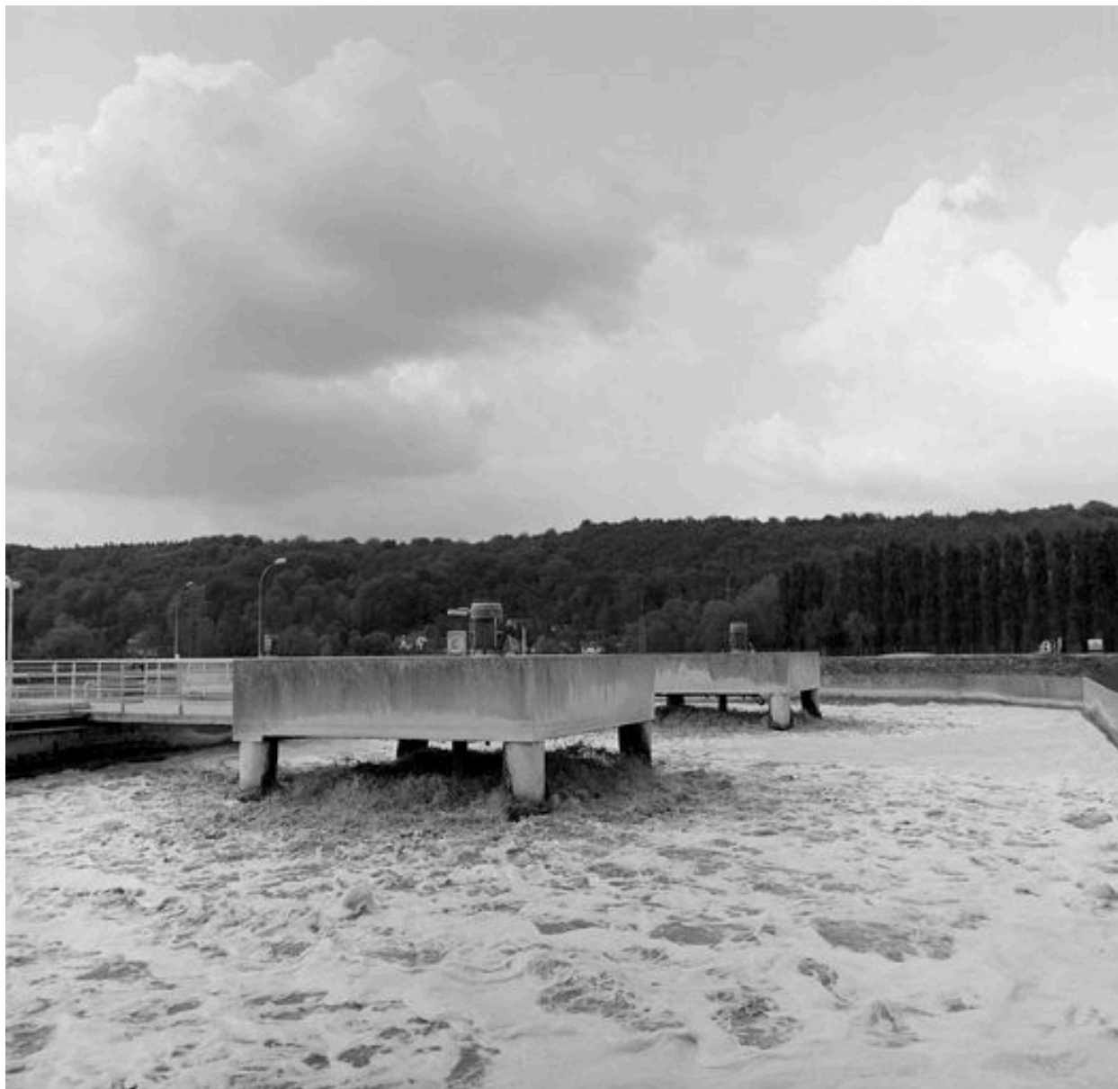
La station d'épuration construite vers 1970.
