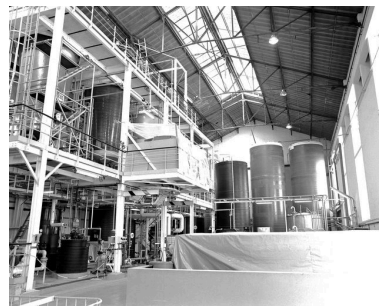
Chaufferie : vue intérieure. Phot. Thierry Lefébure IVR22_19926000369X
