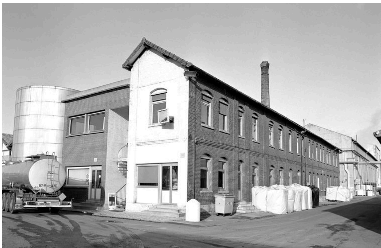
Atelier de fabrication : élévation est.
