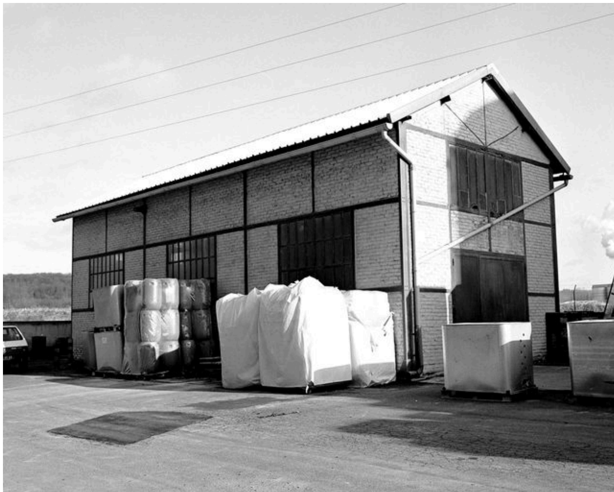
Chaufferie : flanc nord.
