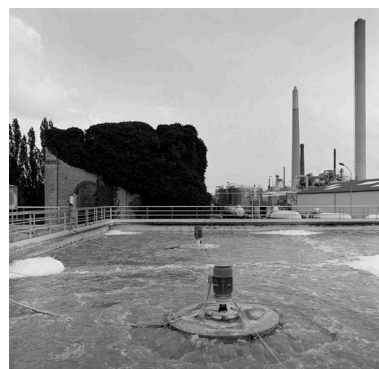
La station d'épuration construite vers 1970 avec les vestiges de l'ancienne savonnerie à l'arrière plan. Phot. Patrick Glotain IVR22_19936000552X
