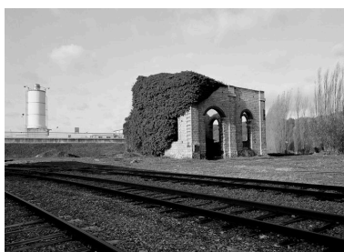
Ancien atelier de fabrication de la savonnerie. Phot. Thierry Lefébure IVR22_19926000353X
