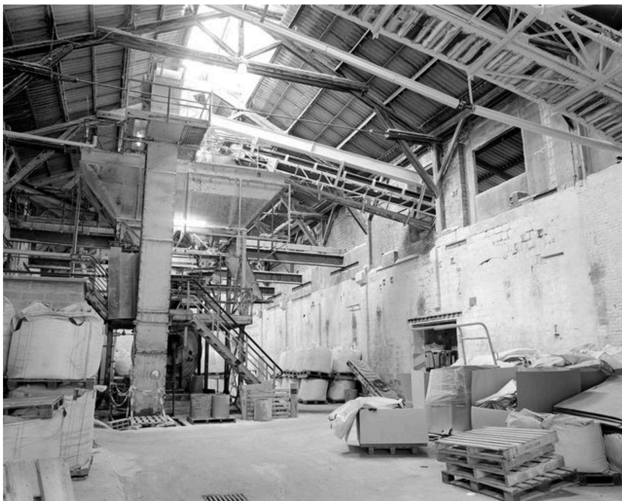
Atelier de fabrication : vue intérieure.
