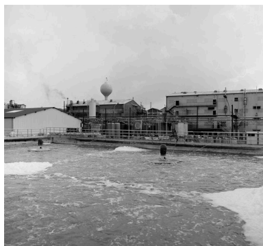
La station d'épuration construite vers 1970.
