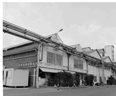
Atelier de fabrication antérieur à 1960. Phot. Patrick Glotain IVR22_19936000535X
