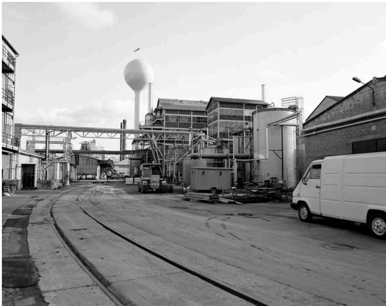
Atelier de fabrication et château d'eau.
