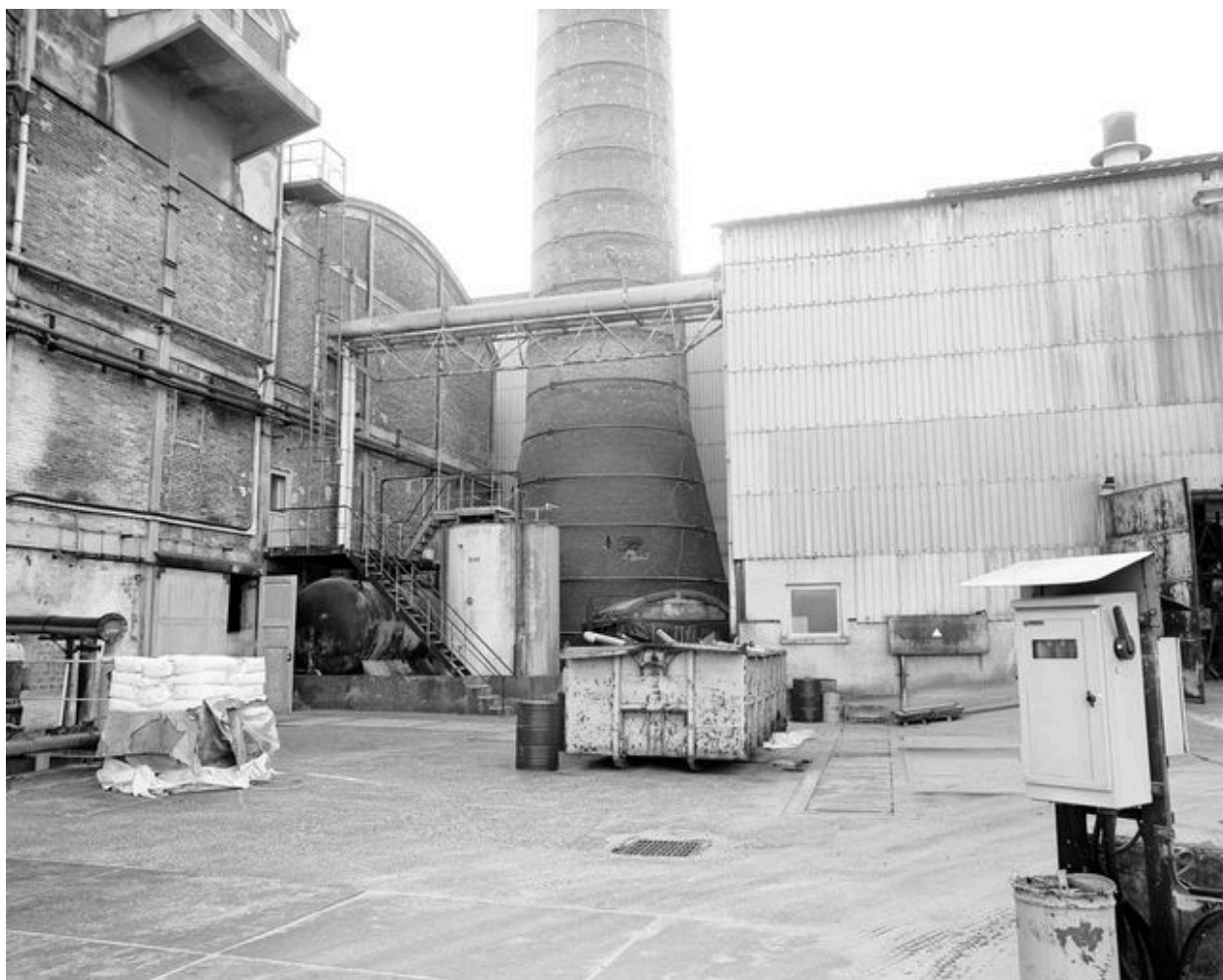
Détail du socle de la cheminée d'usine, construite en 1897.
