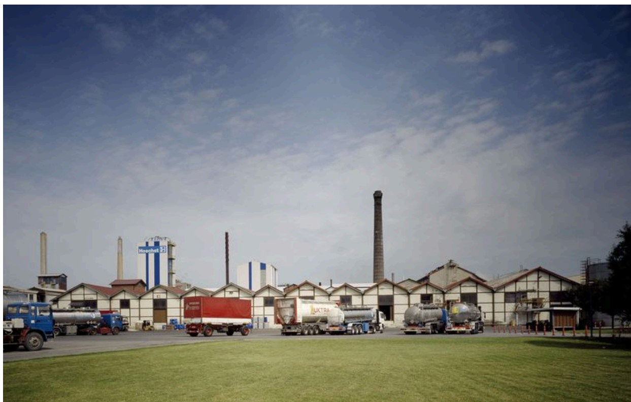
Ateliers de fabrication : flanc sud.
