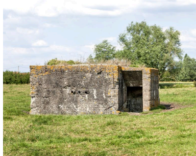
Elévation ouest et une des deux entrées, au sud. Phot. Jean-Marc Ramette IVR31_20145905361NUCA
