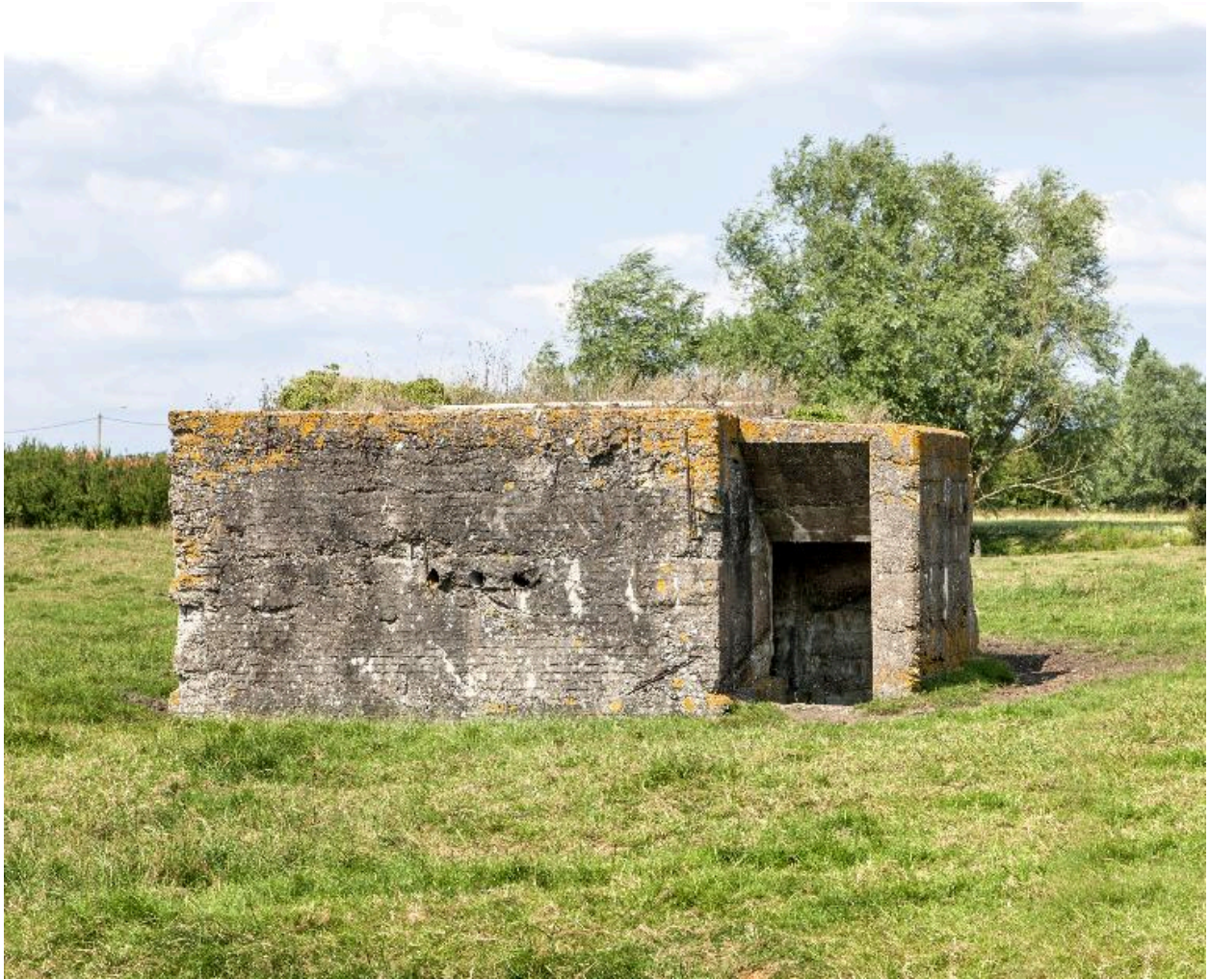
Elévation ouest et une des deux entrées, au sud.
