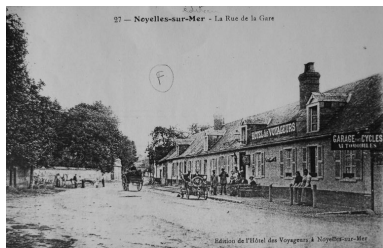
Vue ancienne de l'Hôtel des Voyageurs depuis l'ouest. Phot. Inès Guérin IVR22_20058005397NUCAB
