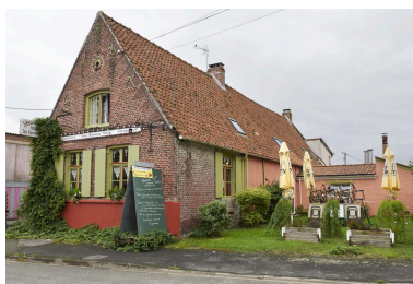
Pignon est et façade nord. Phot. Delphine Volto Jourdan IVR32_20245902952NUCA
