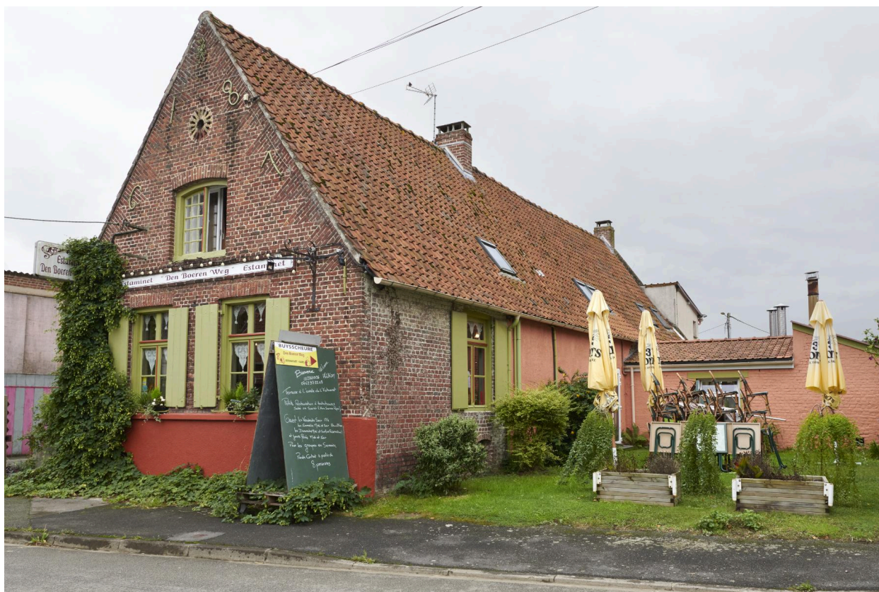
Pignon est et façade nord.
