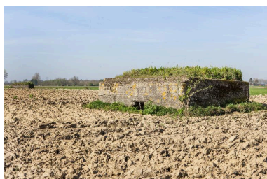
Vue générale vers l'ouest. On aperçoit l'entrée à demi enterrée. A l'arrière plan une casemate à personnel (IA59004902) Phot. Jean-Marc Ramette IVR31_20145905021NUCA
