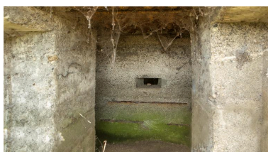
Depuis l'embrasure de l'entrée, le couloir de distribution et, en face, un créneau de fusillade Phot. Jean-Marc Ramette IVR31_20145905023NUCA
