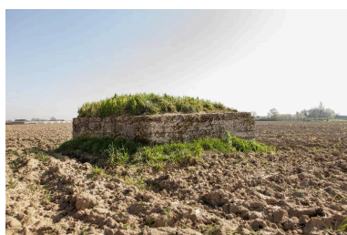
Vue de trois-quarts arrière; vers l'est Phot. Jean-Marc Ramette IVR31_20145905024NUCA
