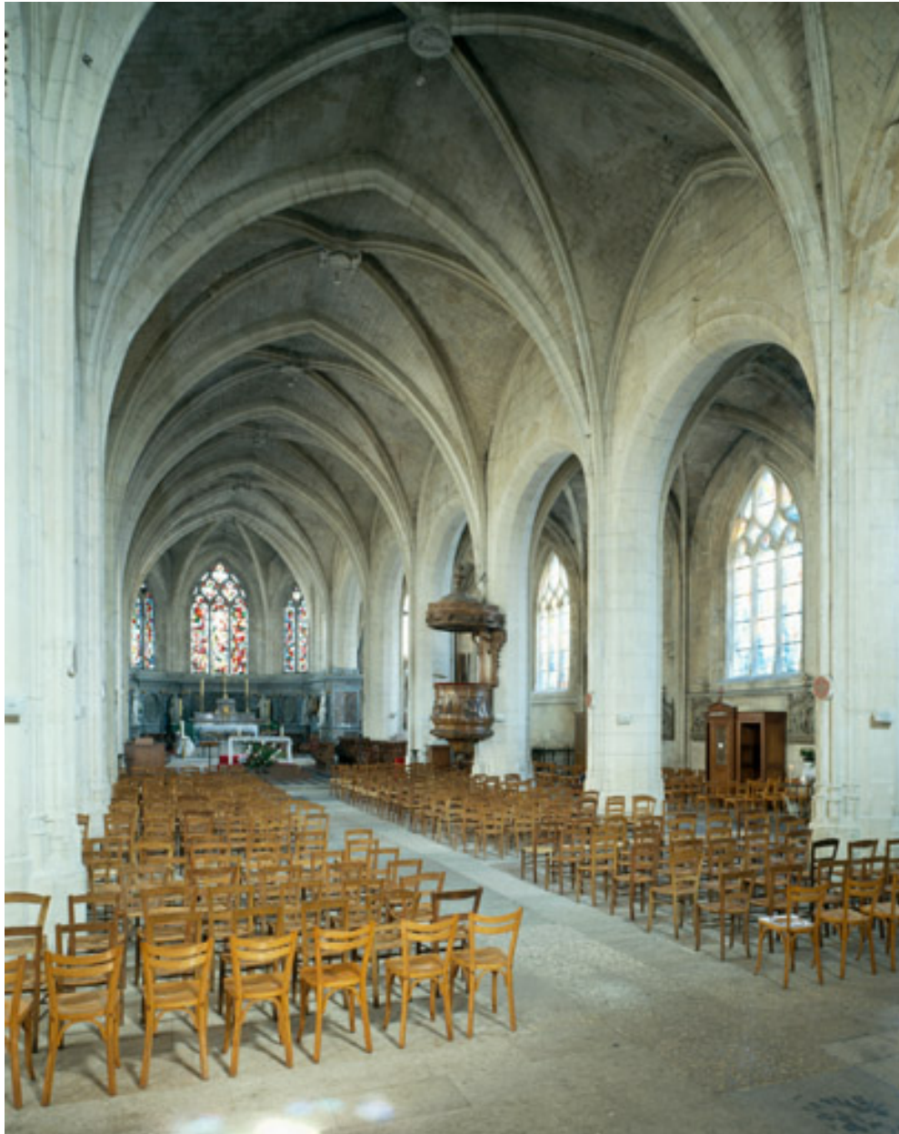
Vue générale de la nef, en direction du chœur.
