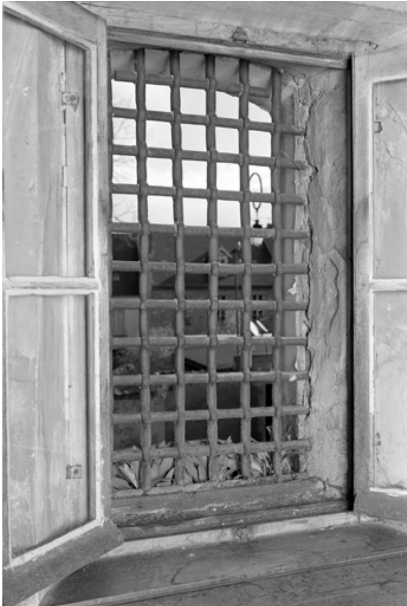
Grille de clôture, fenêtres de la sacristie de l'église Saint-Crépin, 16e siècle.
