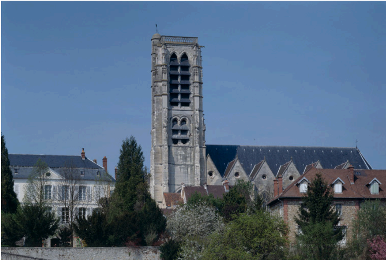
Vue de situation depuis la Marne.
