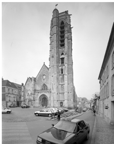
Vue générale de la façade occidentale et du parvis depuis la rue Saint-Crépin. Phot. Patrick Glotain IVR22_19930200504V
