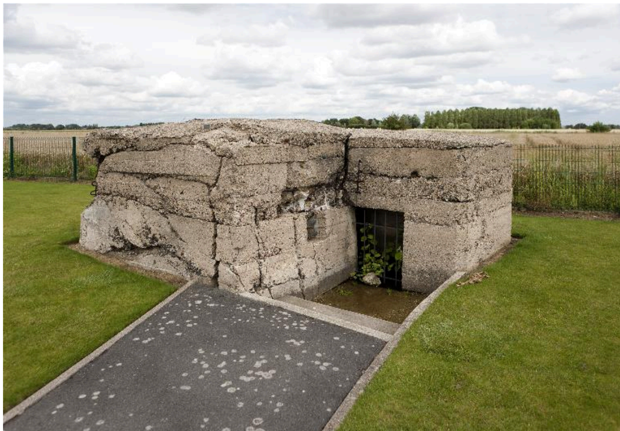
Casemate (f), vers le nord-est
