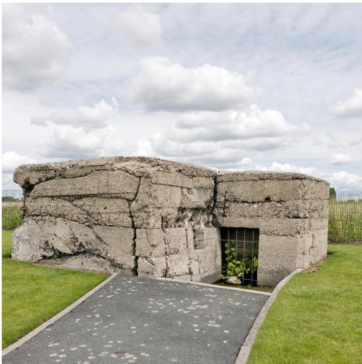
Casemate (f), vers le nord-est
