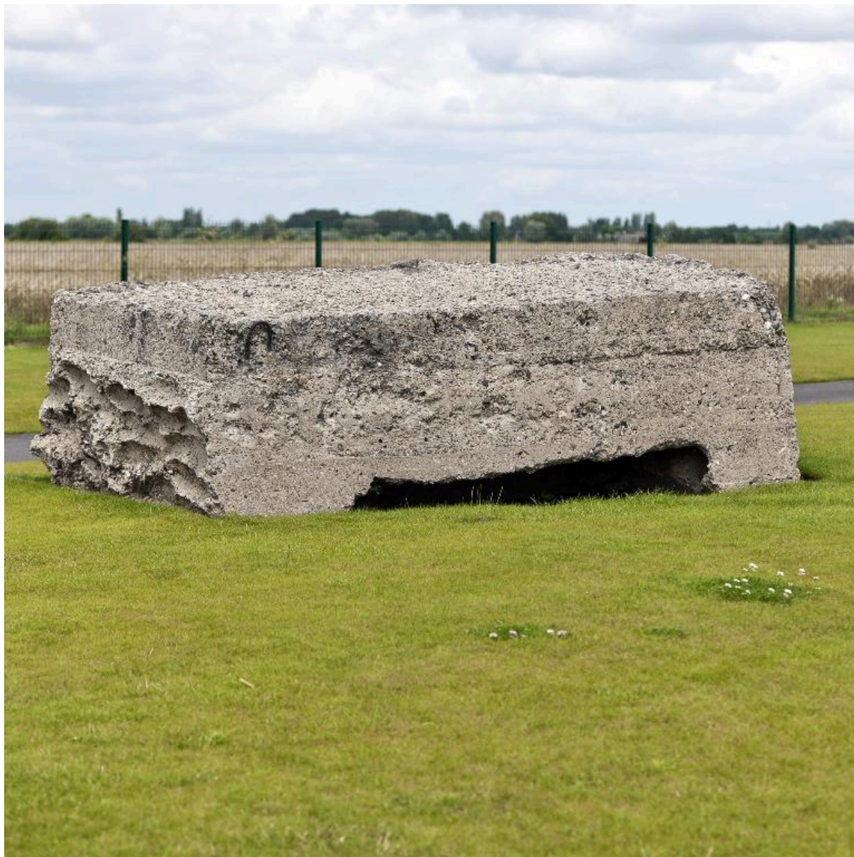
La casemate (a), vers le nord-ouest
