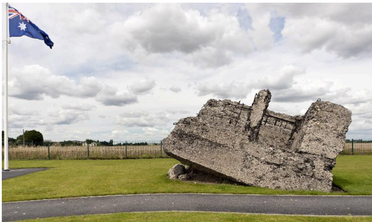
Vestiges de la casemate (e) retournée lors de l'explosion d'une mine, vers le nord
