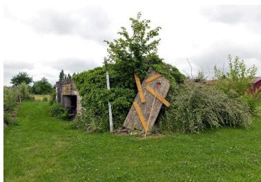
Vue vers le sud Phot. Jean-Marc Ramette IVR31_20145904104NUCA
