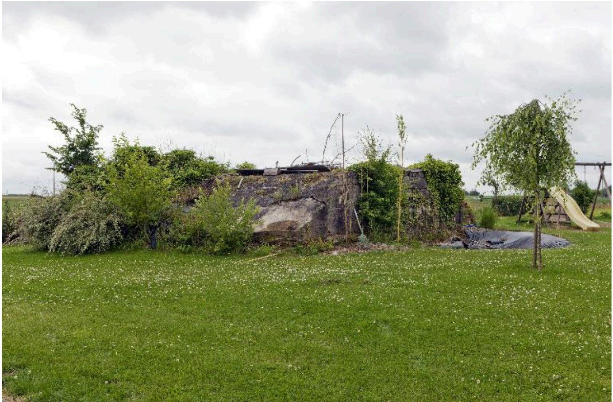
Vue vers le sud-est
