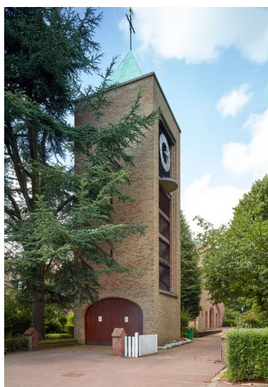
Vue de la tour clocher. Phot. Pierre Thibaut IVR31_20155901563NUCA
