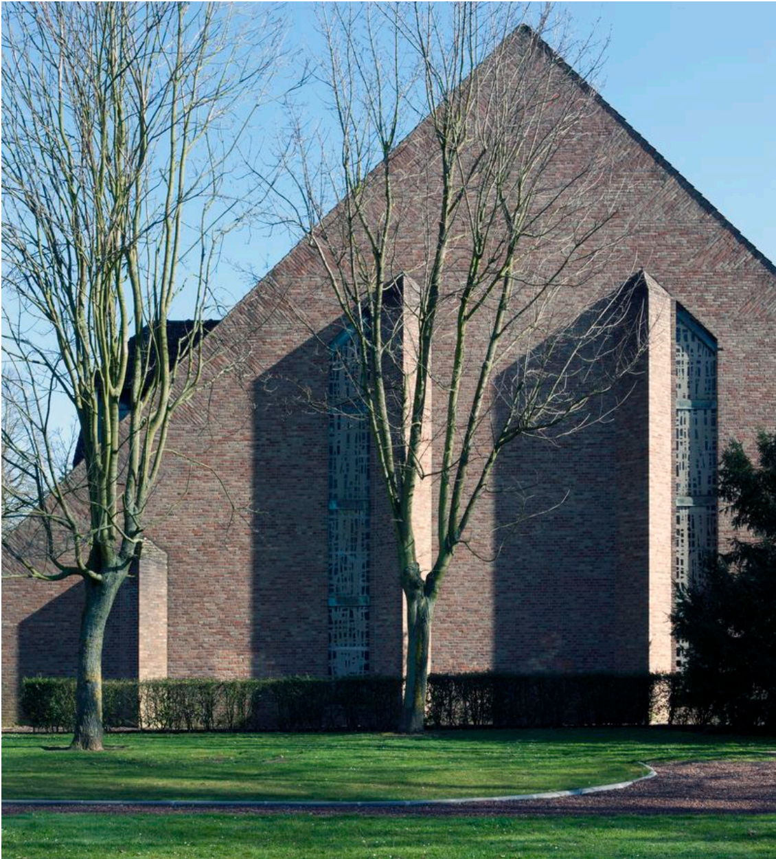
Contrefort de l'élévation sud.
