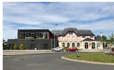
Vue générale de la façade principale de l'ancien buffet de la Gare et de son extension contemporaine. Phot. Bertrand Fournier IVR32_20170205227NUC2A
