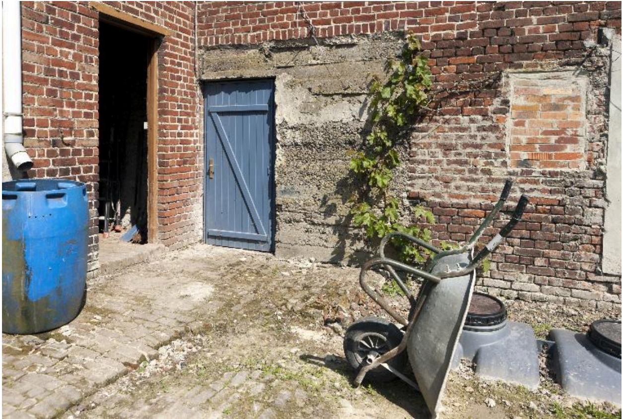
Entrée de la casemate sur la cour de la ferme, vers le nord.
