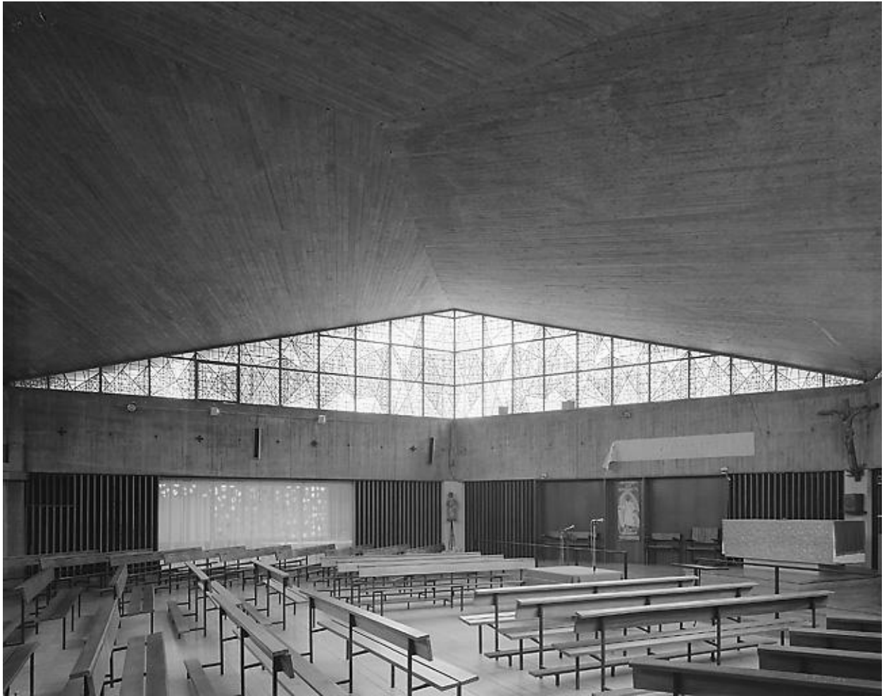
Verrières n° 1 et 6, vue d'ensemble.
