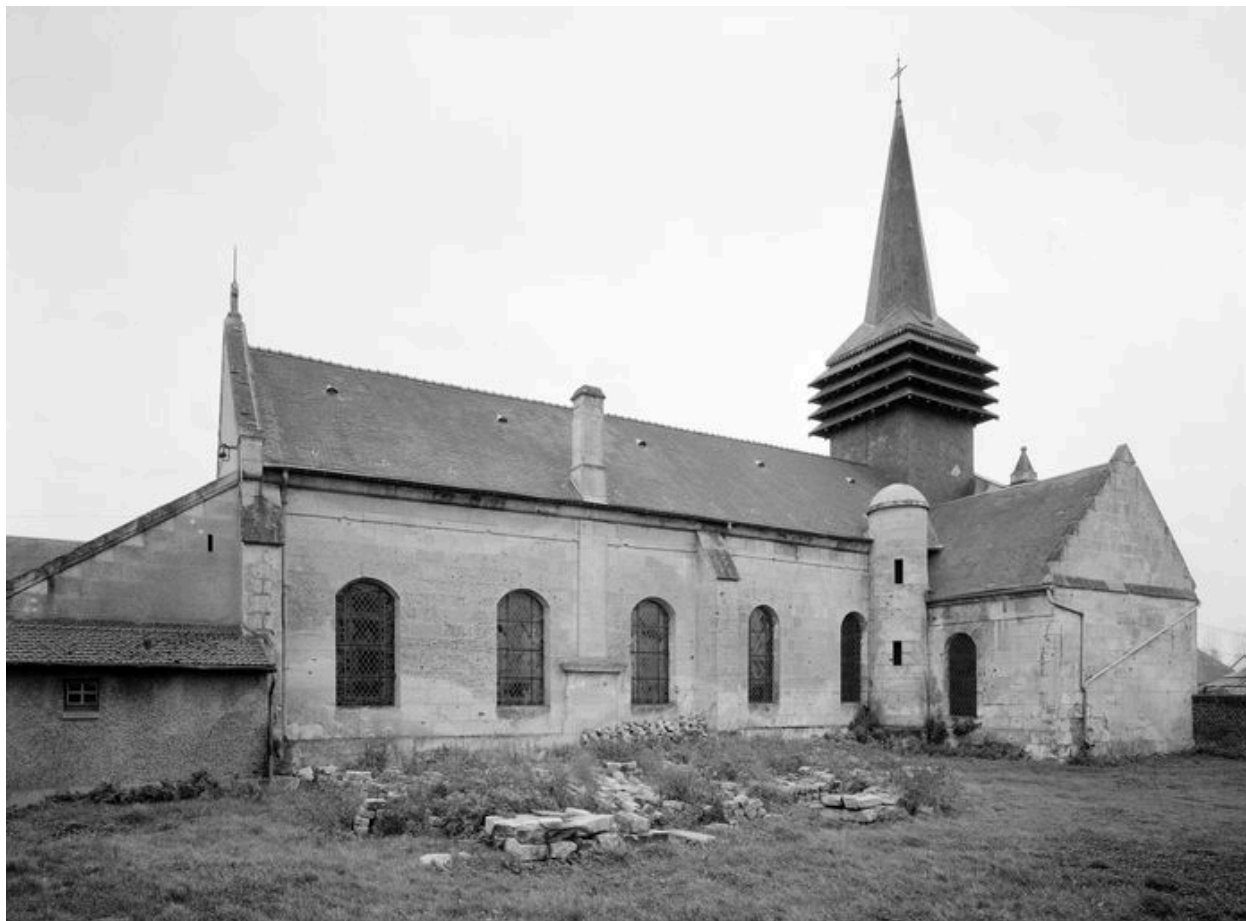
Elévation nord de l'église.
