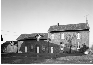
Vue générale. Phot. Thierry Lefébure IVR22_19960201037V
