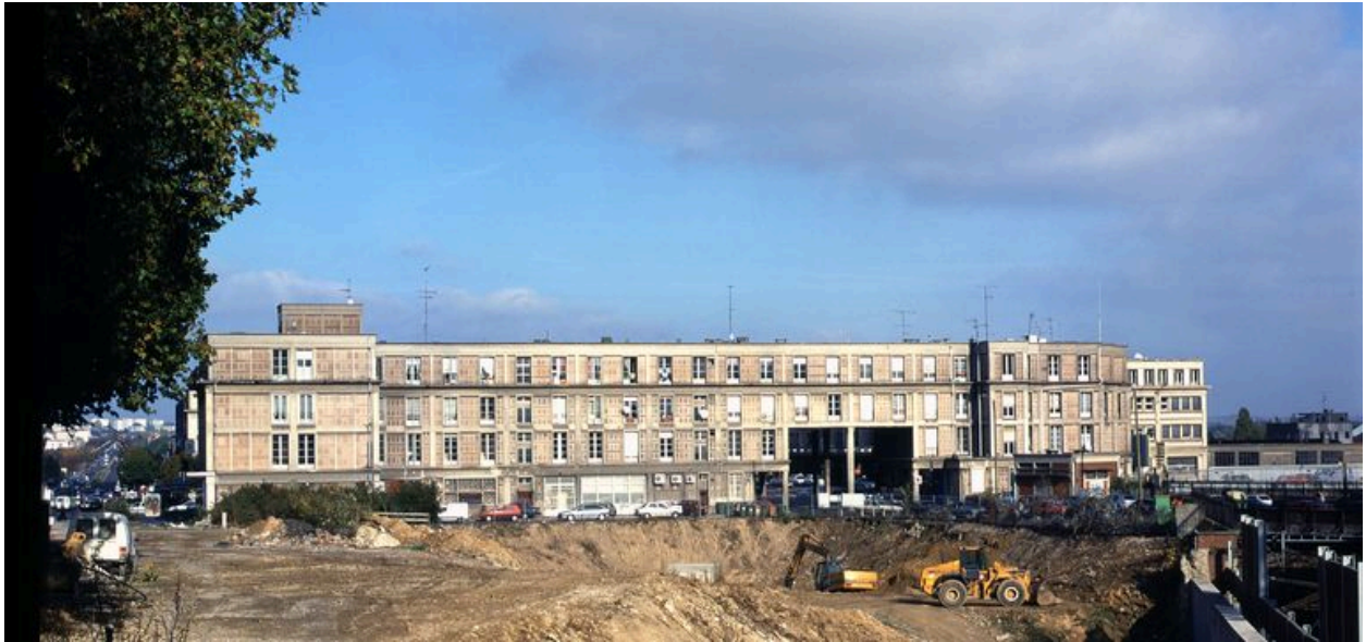
Façade sud de l'immeuble.
